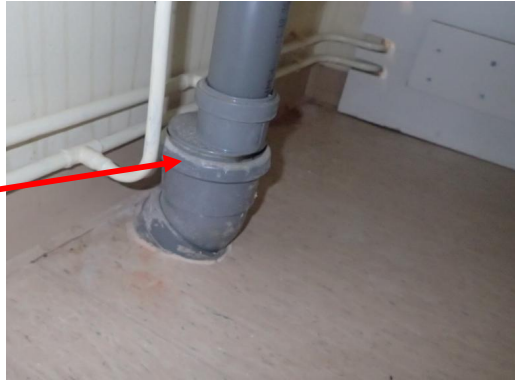
Kuva 61. Viemäriiliitos sijaitsee kaapin sokkelin sisällä
