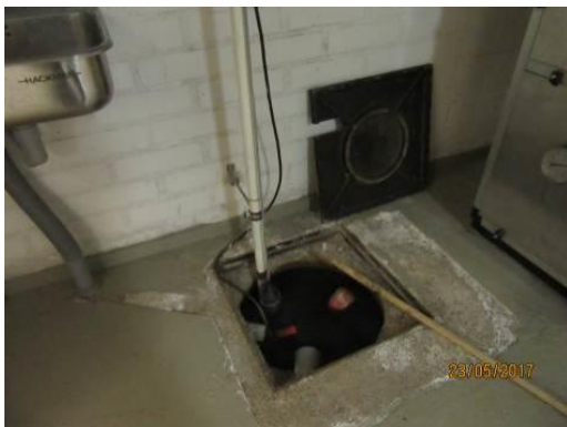
Kuva 23. Kaivo yläasteen lämmönjakohuoneessa
