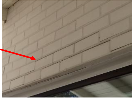
Kuva 27. Halkeilua sokkelissa
