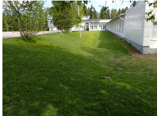
Kuva 2. Maanpintojen kallistukset rakennuksesta poispäin vähäiset
