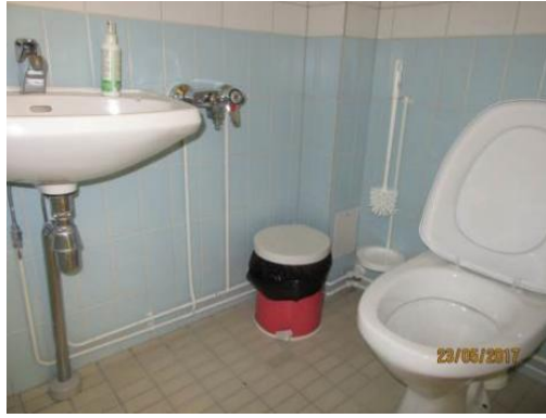
Kuva 8. Vesi- ja viemärikalusteet ovat kokonaisuutena tyydyttävässä kunnossa
