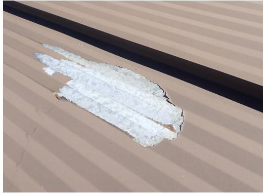
Kuva 44. Pinnoitevaurio peltikatteessa
