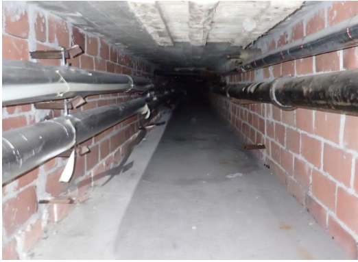
Kuva 15. Itäsiiven kohdalla sijaitseva putkikanaali on alipaineistettu.
