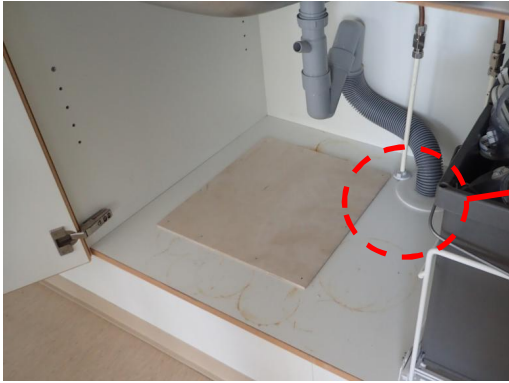
Kuva 60. Yleiskuvaa luokan 5 käsienvesualtaan alakaapista.
