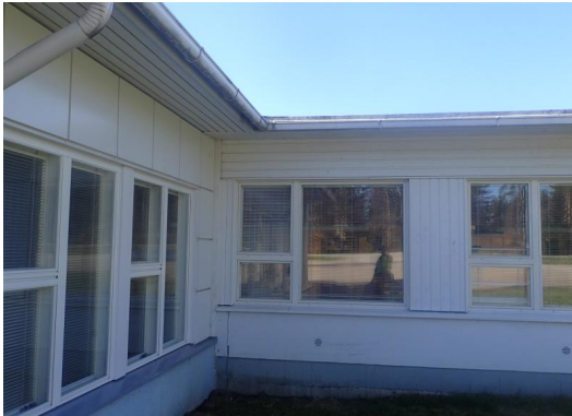
Kuva 18. Yleiskuva yläasteen julkisivusta
