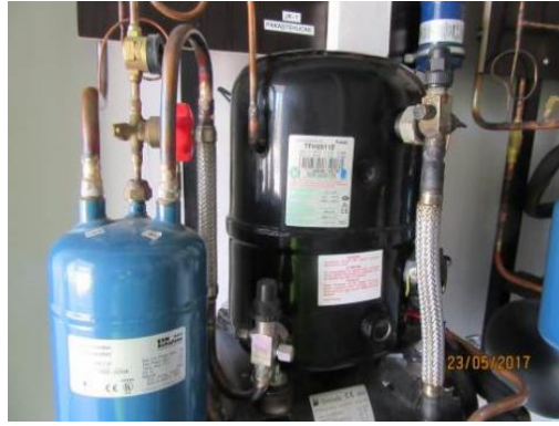
Kuva 40. Jäähdytyskompressori
