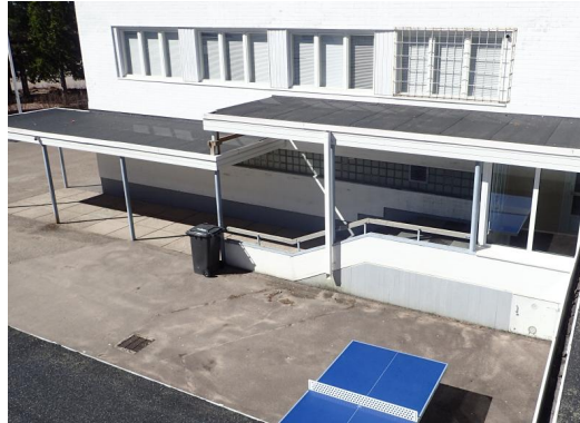
Kuva 37. Yläasteen teräsrakenteinen katos
