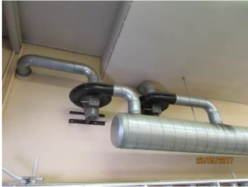
Kuva 47. Kohdepoistopuhaltimet
