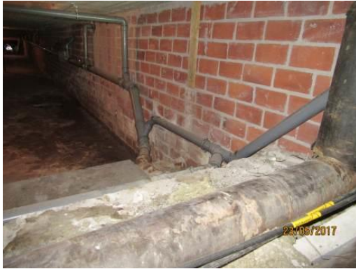
Kuva 17. Muoviviemärit liitetty alurautaviemäriin
