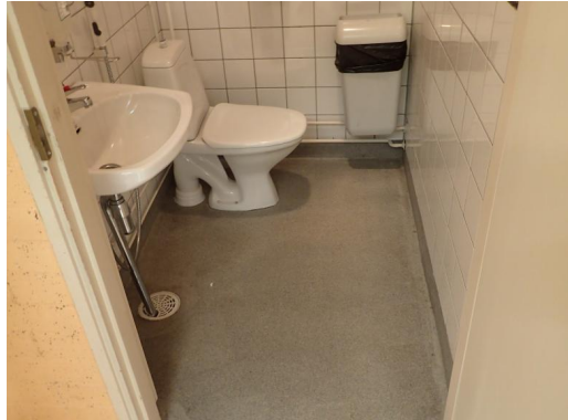
Kuva 76. Yläasteella sijaitseva wc-tila
