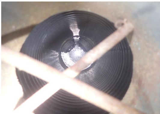
Kuva 10. Salaojan tarkastuskaivo
