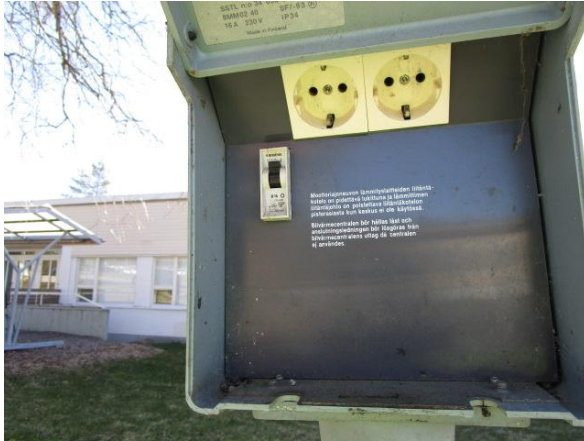
Kuva 51. Vanhempia autolämmityskoteloita
