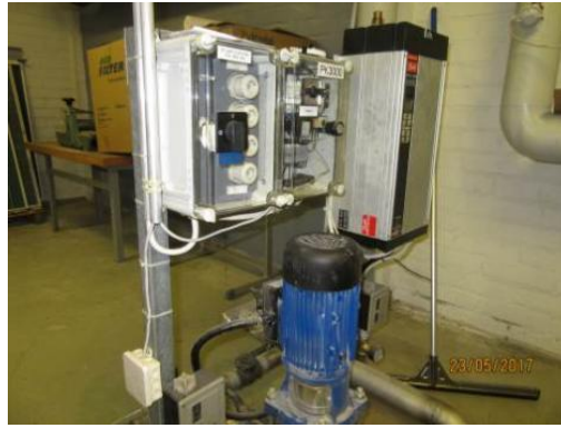
Kuva 6. Yläasteen paineenkorotuskoneikko
