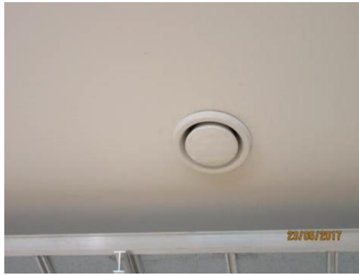
Kuva 36. Opetustilan poistoilmaventtiili
