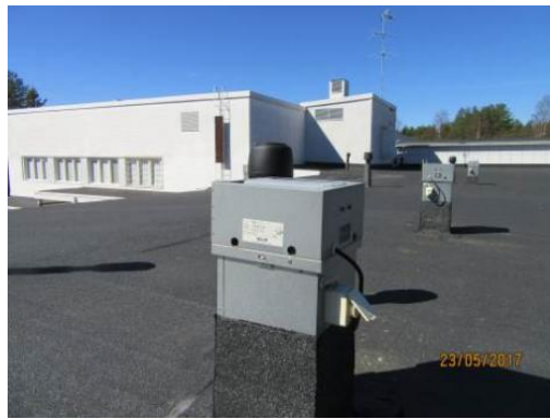
Kuva 30. Huippuimureita
