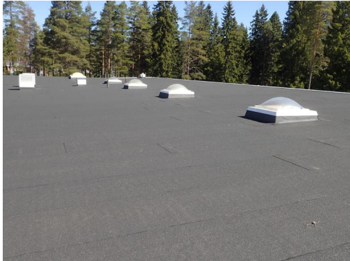
Kuva 40. Yleiskuvaa vesikatolta yläasteen osuudelta
