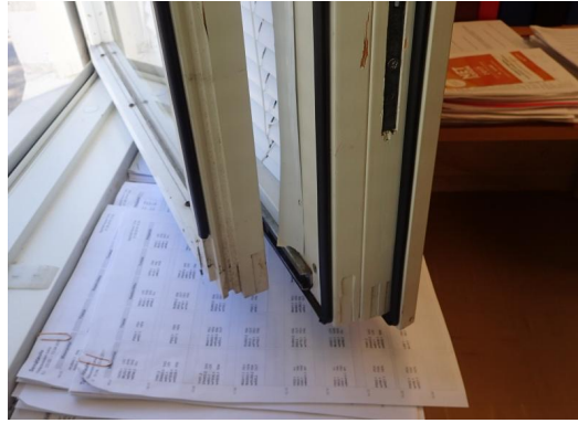
Kuva 30. Lukion laajennuksen puuikkuna
