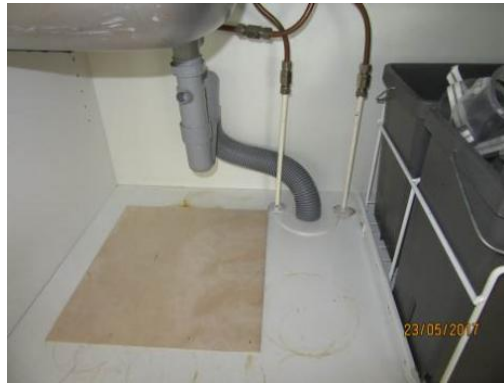
Kuva 12. Kalusteiden pohjaan tulisi asentaa vesitiivis pinnoite
