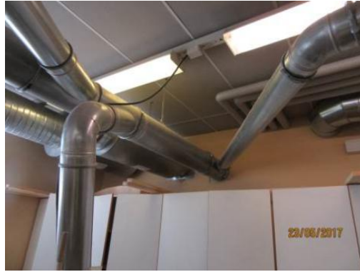
Kuva 44. Purunpoistokanavia
