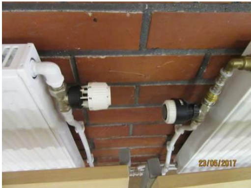
Kuva 3. Patteriventtiilit
