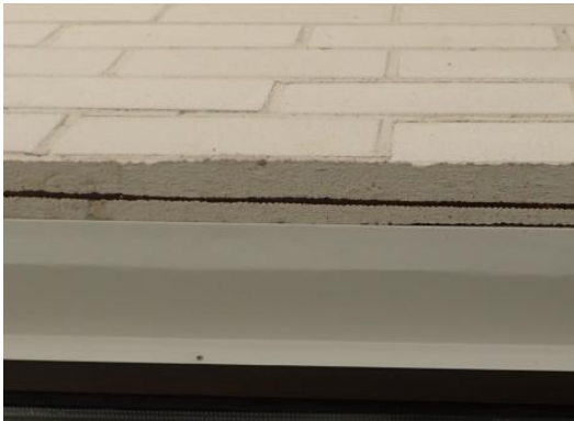
Kuva 28. Oven ylituskohdassa kantavana rakenteena raudoitteet + laastivalu
