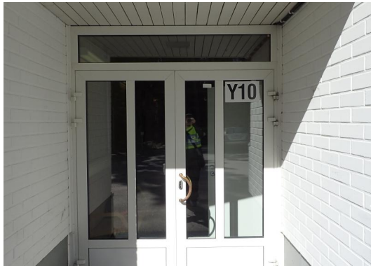
Kuva 34. Ulko-ovet ovat pääosin metallirunkoisia, lasiaukollisia ovia.
