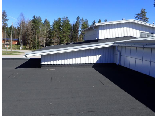
Kuva 41. Yleiskuvaa keittiön laajennuksen vesikatolta
