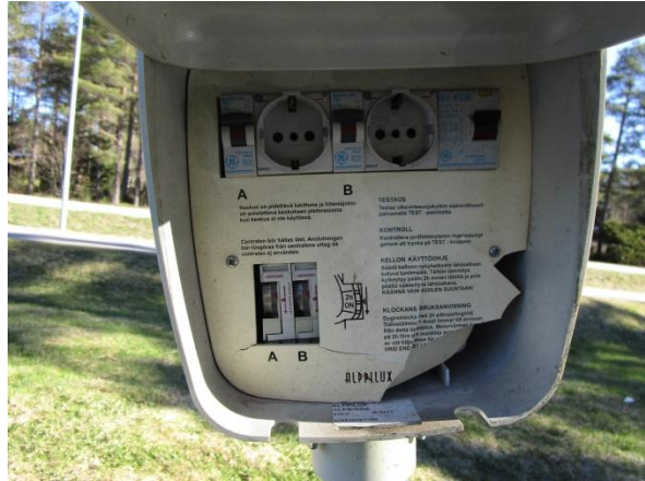
Kuva 52. Rikkinäinen autolämmityskotelo
