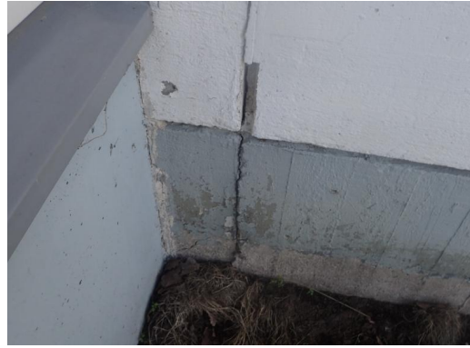
Kuva 22. Halkeilua sokkelissa
