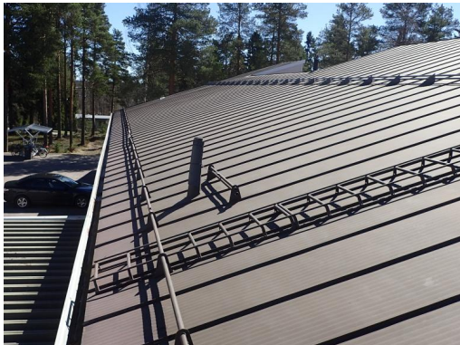
Kuva 42. Yleiskuvaa lukion vesikatolta
