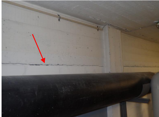
Kuva 69. Halkeilua kellarin seinässä
