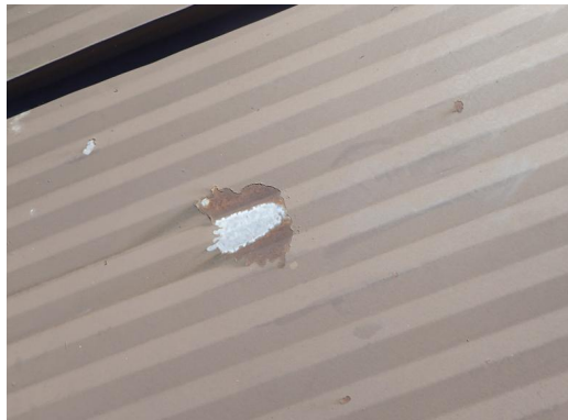
Kuva 46. Vesikatteessa korroosiovaurio
