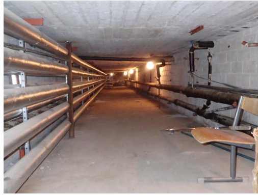
Kuva 16. Länsisiiven kohdalla sijaitseva putkikanaali
