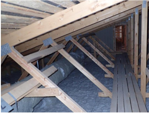
Kuva 43. Yleiskuva yläpohjasta lukion kohdalta
