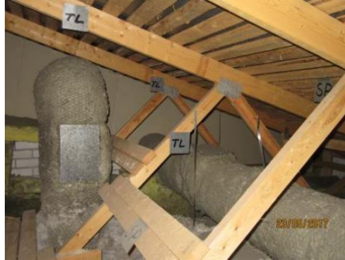
Kuva 34. Ilmanvaihtokanavien eristykset ovat kunnossa ja riittävät
