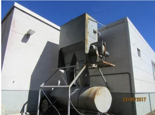
Kuva 43. Purunpoistomuri ja suodatinyksikkö
