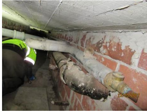
Kuva 18. Valurautaviemäri käytöstä poistetun vesijohdon alapuolella
