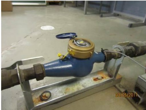
Kuva 5. Yläasteen vesimittari
