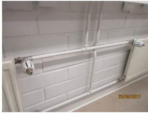
Kuva 2. Patteriventtiilit
