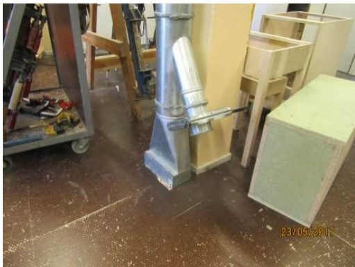
Kuva 45. Purunpoistojärjestelmän kohdepoisto
