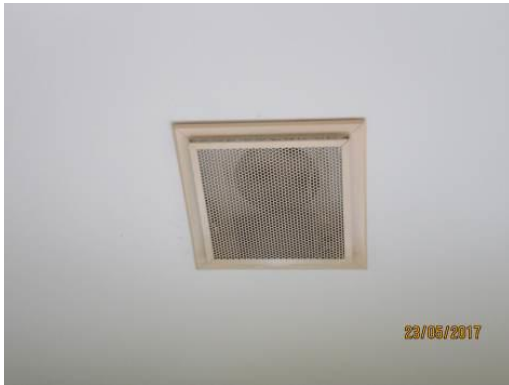
Kuva 35. Opetustilan tuloilmaventtiili
