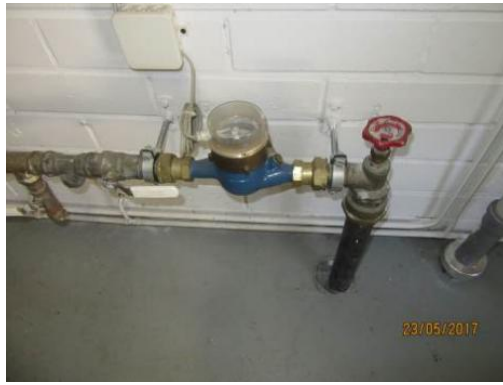
Kuva 10. Lukion vesimittari
