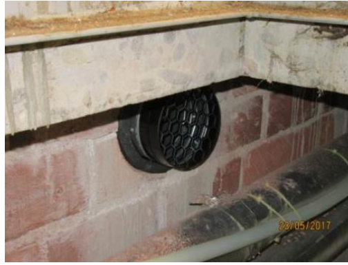
Kuva 32. Putkitunnelin alipaineistus
