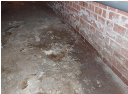
Kuva 17. Länsisiiven putkikanaalissa monin paikoin kosteuden aiheuttamia jälkiä
