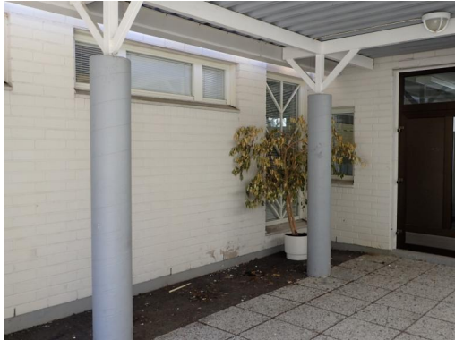
Kuva 36. Lukion sisäänkäynnin katos
