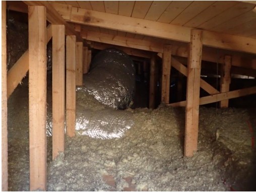
Kuva 48. Yleiskuva yläpohjasta keittiön kohdalta
