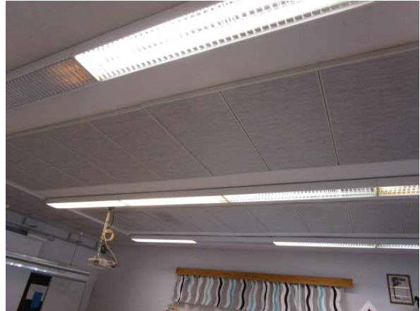
Kuva 116. Vanhan koulun valaisimia (puuttui suojakupu). Kuva 117. Näkymä loistevalaisimista luokassa.
