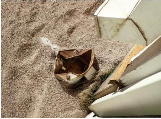
Kuva 11. Rännikaivona peltiämpäri
