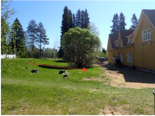
Kuva 5. Vanhan koulun pohjoispuolella maanpinta viettää kohti rakennusta
