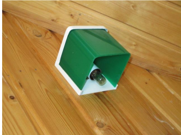
Kuva 123. Poistumistievalaisimia (vanha koulu).
