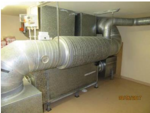
Kuva 94. Lisärakennuksen ilmanvaihtokone
