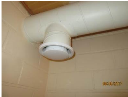
Kuva 101. Poistoilmaventtiili
