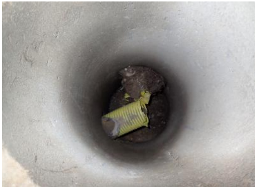
Kuva 16. Salaojan tarkastuskaivo vanhan koulurakennuksen vierustalla
