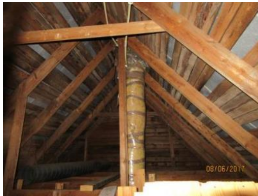
Kuva 99. Lämpöeristetty jäteilmakanava
