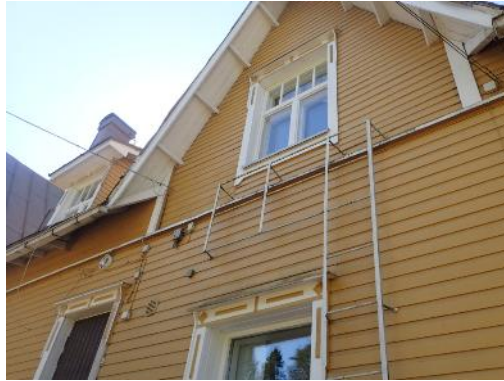
Kuva 39. Hätäpoistumistietikkaissa korroosioaurioita
