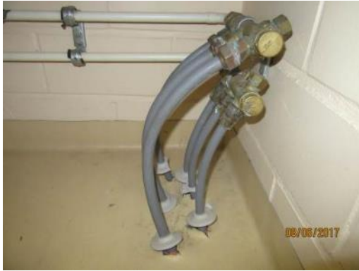
Kuva 84. Upolet muoviputkia lisärakennuksessa
