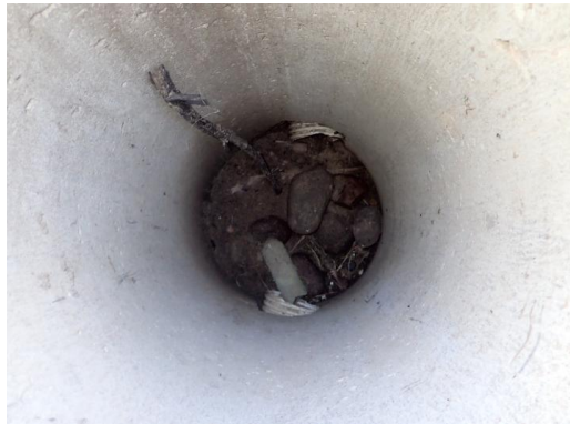
Kuva 17. Salaojan tarkastuskaivo lisärakennuksen vierustalla
