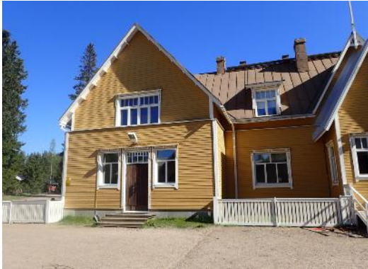
Kuva 21. Yleiskuva vanhan rakennuksen julkisivusta
