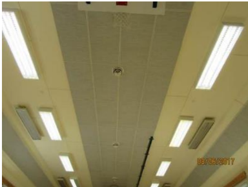
Kuva 100. Liikuntasalin tuloilmaventtiilit
