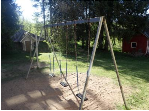
Kuva 8. Kiikun teräsosissa korroosiovaurioita
