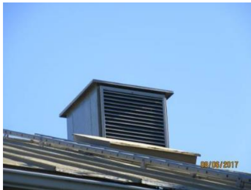
Kuva 95. Ilmanvaihtokoneen ilmanotto/ulospuhalluslaite
