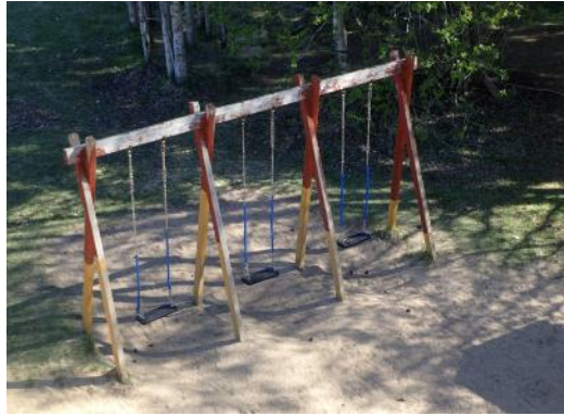
Kuva 9. Puisen kiikun maalipinnoitteet ovat kuluneet
