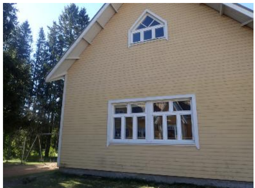
Kuva 26. Yleiskuuvaa lisärakennuksen julkisivusta
