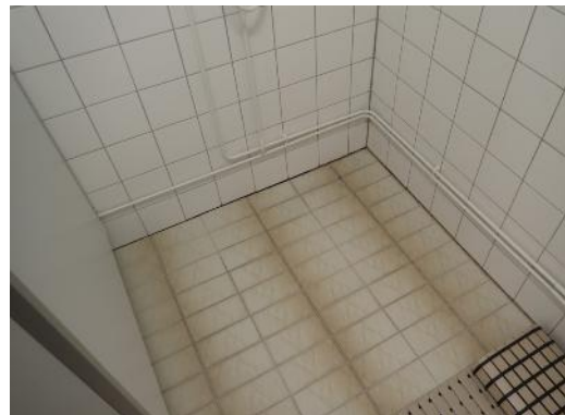
Kuva 72. Yleiskuva lisärakennuksen pesuhuoneesta
