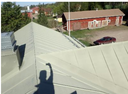
Kuva 44. Yleiskuva lisärakennuksen vesikatolta
