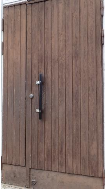
Kuva 34. Vanhan koulurakennuksen ulko-ovi
