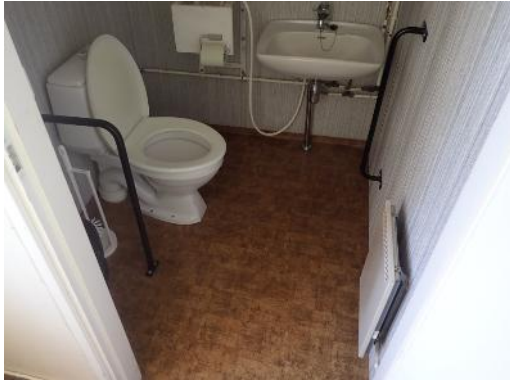
Kuva 69. Yleiskuva vanhan koulurakennuksen wc-tilasta
