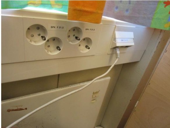
Kuva 112. Uusia kouruasennuksia.
