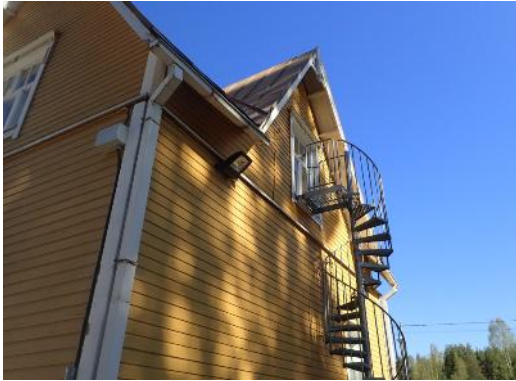
Kuva 38. Vanhan koulurakennuksen hätäpoistumistie
