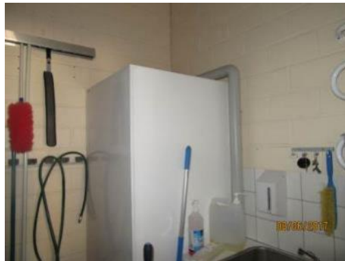
Kuva 81. Lisärakennuksen lämminvesivaraaja
