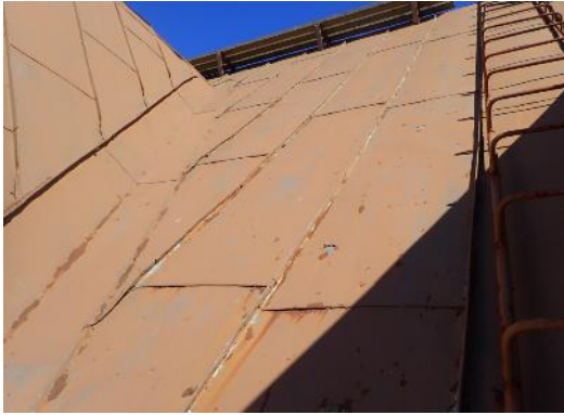
Kuva 50. Yleiskuva vanhan koulurakennuksen vesikaton
