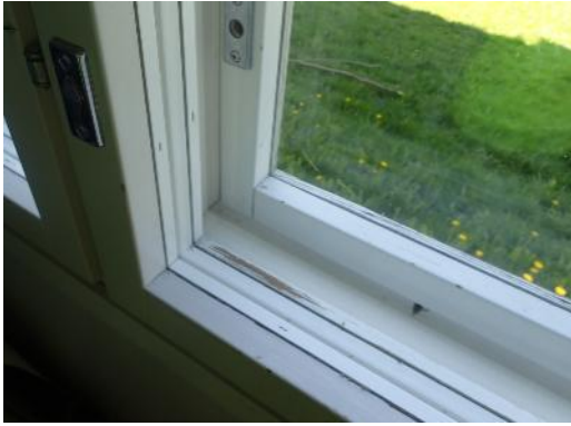
Kuva 28. Vanhan koulurakennuksen avattava puuikkuna.
