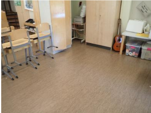
Kuva 62. Vanhan koulurakennuksen lattian muovimatto
