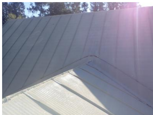
Kuva 45. Yleiskuva lisärakennuksen vesikatolta
