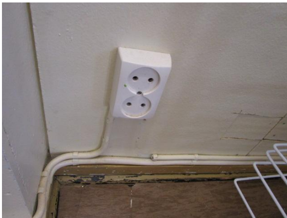
Kuva 114. Vanhan koulun asennuksia.
