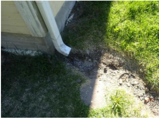
Kuva 13. Lisärakennuksen osuudella kattovedet on ohjattu maahan
