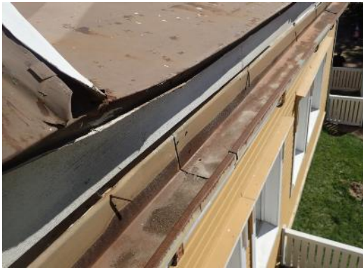
Kuva 52. Rännikouruissa ruostevaurioita
