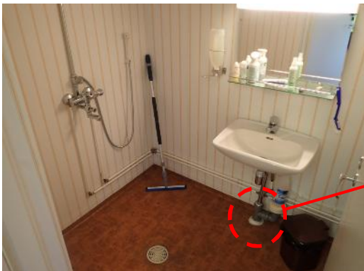
Kuva 75. Yleiskuva vanhan koulurakennuksen pesuhuoneesta
