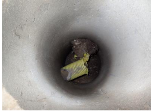
Kuva 6. Salaojajärjestelmän tarkastuskaivo
