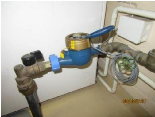
Kuva 80. Vesimittari
