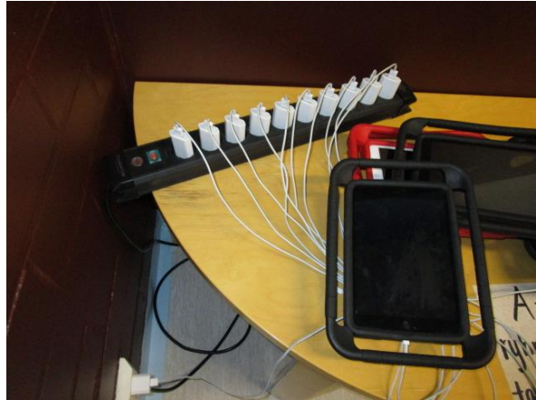
Kuva 51. Mobiililatauspiste (osin turvallisuusriski).
