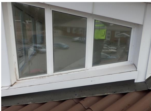
Kuva 25. Yleiskuva valokuilun ikkunoista
