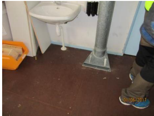
Kuva 39. Purunpoistojärjestelmän kohdepoisto
