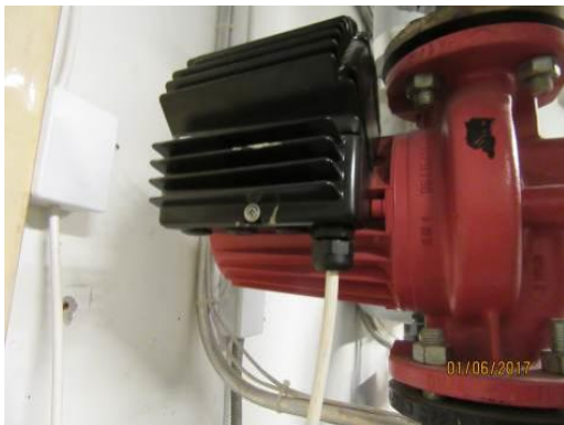
Kuva 60. Lämmitysverkoston kiertovesipumppu
