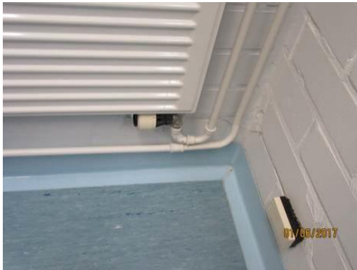
Kuva 1. Termostaattinen patteriventtiili irtoanturilla
