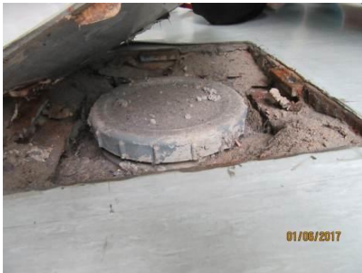
Kuva 8. Pohjaviemäriin puhdistusyhteys
