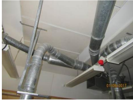
Kuva 37. Purunpoistokanavia
