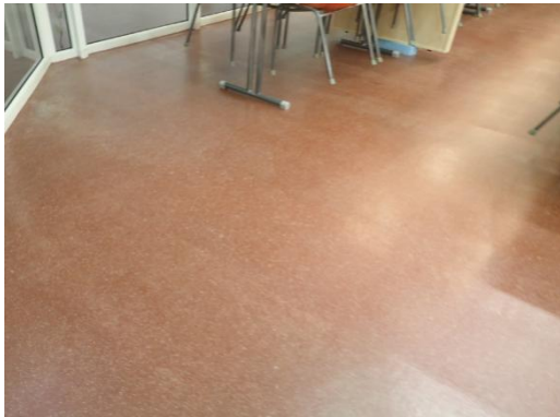
Kuva 46. Ruokalassa lattiapinnoite akryylibetonia
