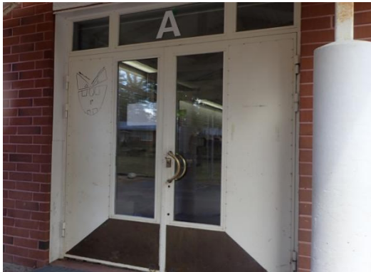
Kuva 26. Ulko-ovet ovat pääosin metallirakenteisia ja lasiaukollisia ovia
