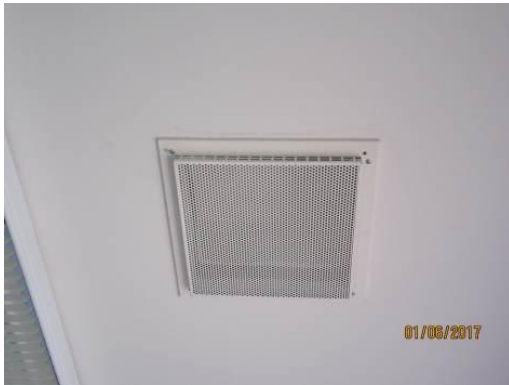
Kuva 26. Opetustilan tuloilmaventtiili
