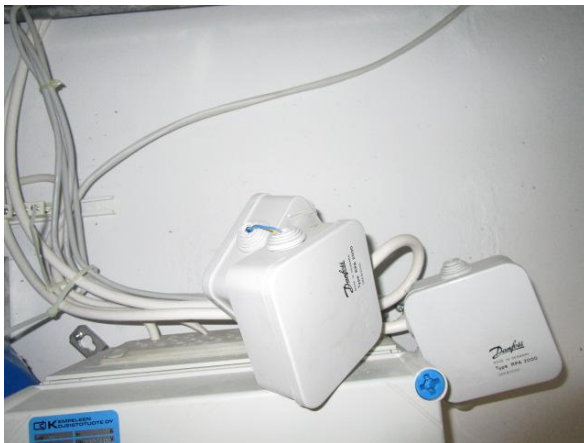
Kuva 52. RK61 tilassa rasioita kiinnittämättä.
