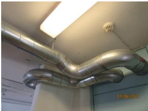
Kuva 24. Ilmanvaihtokanavat ovat hyvässä kunnossa
