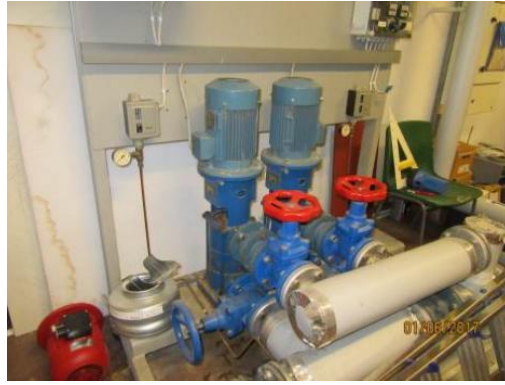
Kuva 3. Paineenkorotuskoneikko
