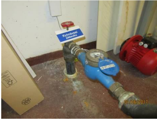
Kuva 2. Vesimittari
