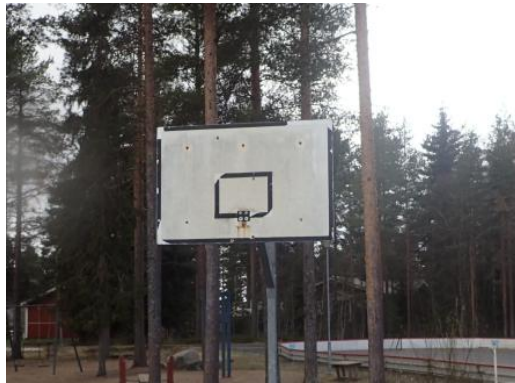
Kuva 6. Koripallotelineestä puuttuu kori
