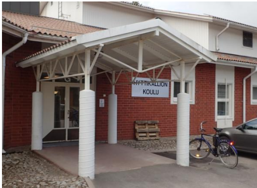
Kuva 30. Yleiskuva sisäänkäynnin katoksesta
