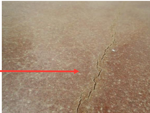
Kuva 53. Lattiapinnoite haljennut
