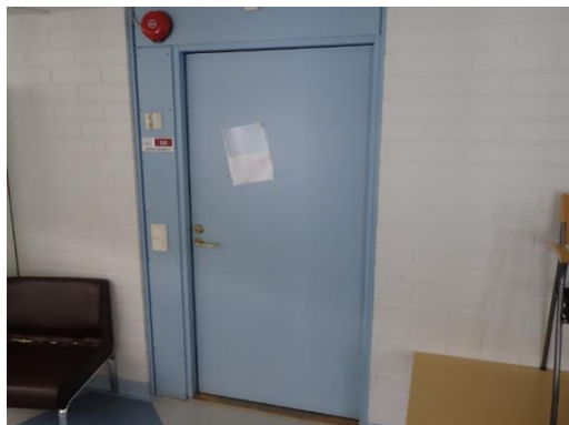
Kuva 29. Yleiskuva puisesta laakaovesta
