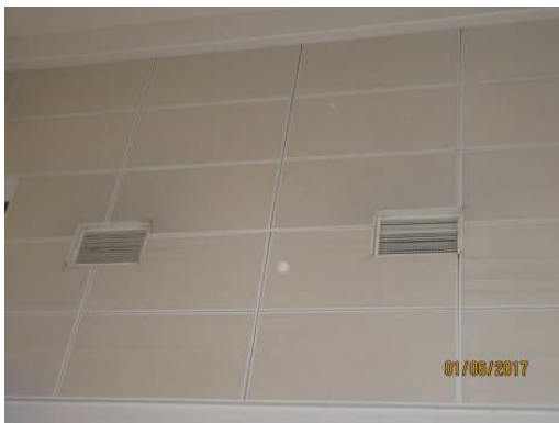
Kuva 30. Liikuntasalin poistoilmaventtiilit
