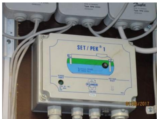
Kuva 11. Öljynerotuskaivon täyttymishälytintä
