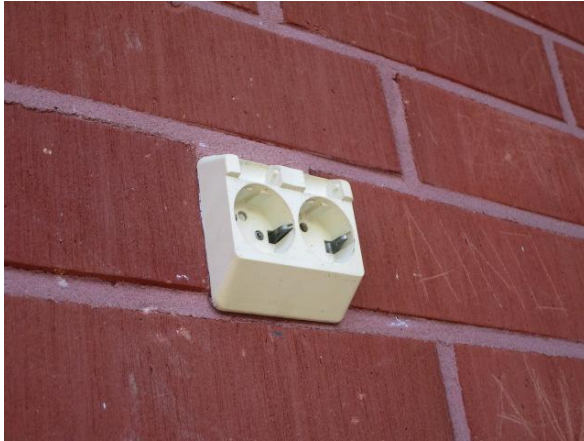
Kuva 50. Alue 2 ulkoseinällä on rasian kansi rikki.
