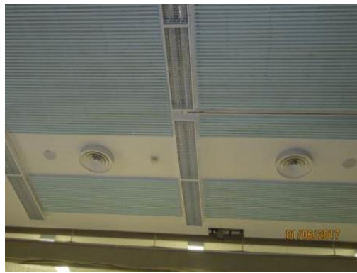
Kuva 29. Liikuntasalin tuloilmaventtiilit
