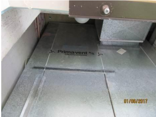
Kuva 36. Purunpoistopuhallin ja suodatinyksikkö
