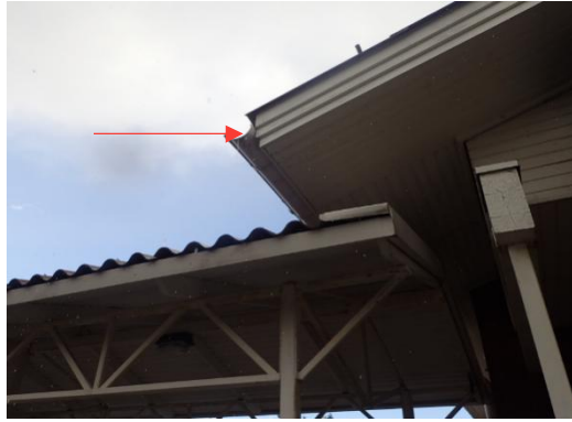
Kuva 9. Sadevesikourun pää auki
