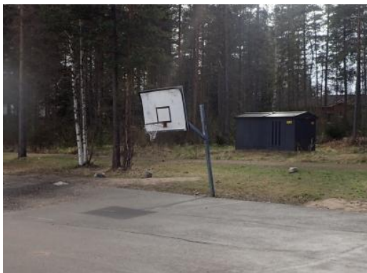
Kuva 7. Toinen koripallokoriteline on kallellaan
