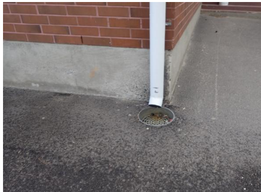
Kuva 11. Kattosadevedet ohjattu syöksyputkin rännikaivoihin
