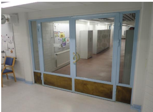
Kuva 28. Yleiskuva metallirunkoisesta lasiovesta
