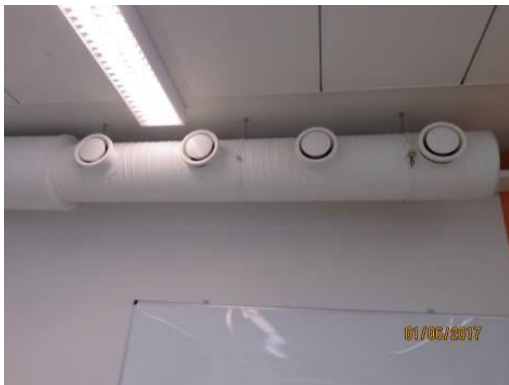
Kuva 28. Opetustilan poistoilmaventtiilit
