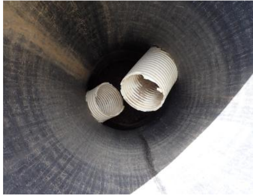
Kuva 14. Salaojaputkien päät nousevat viistosti ylöspäin kaivoon
