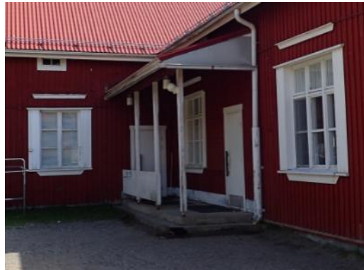
Kuva 43. Punaisen rakennuksen sisäänkäynnin katos
