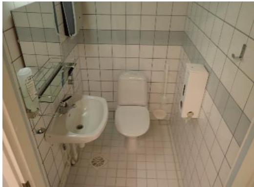
Kuva 73. Pesuhuoneen wc-tilassa lattiat ovat laatoitettut
