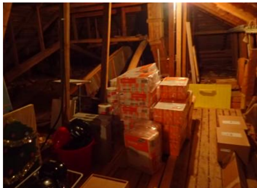
Kuva 59. Yläpohja toimii osittain varastointitilana
