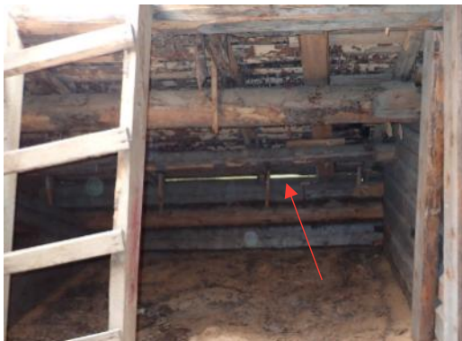
Kuva 54. Tuuletusraot räystäällä
