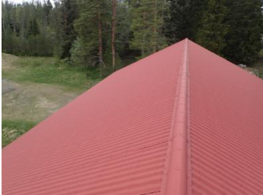
Kuva 44. Yleiskuva monitoimitalon vesikatteesta
