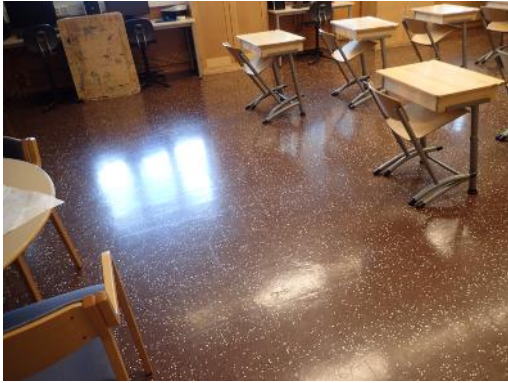
Kuva 63. Punaisen rakennuksen luokkatilassa vinyylilaatta
