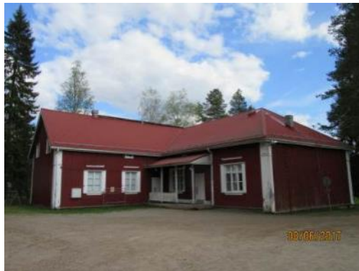
Kuva 60. Punaisen rakennuksen huippuimurit
