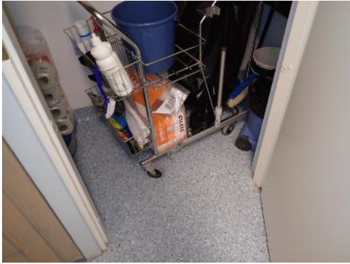
Kuva 78. Yleiskuva monitoimitalon siivoushuoneesta
