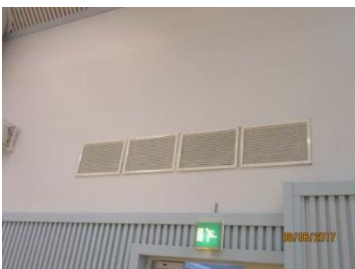
Kuva 65. Liikuntasalin poistoilmaventtiilit
