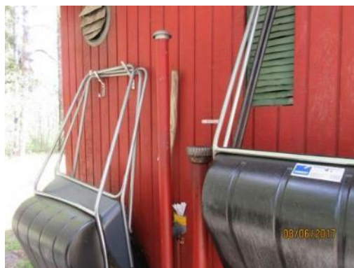
Kuva 88. Öljysäiliön täyttö- ja ilmaputki sekä ylitäytön estin
