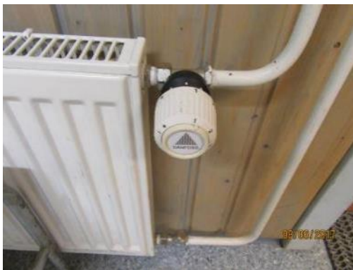
Kuva 90. Patteriventtiili
