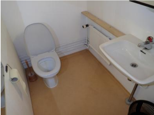
Kuva 68. Yleiskuva keltaisen rakennuksen wc-tilasta
