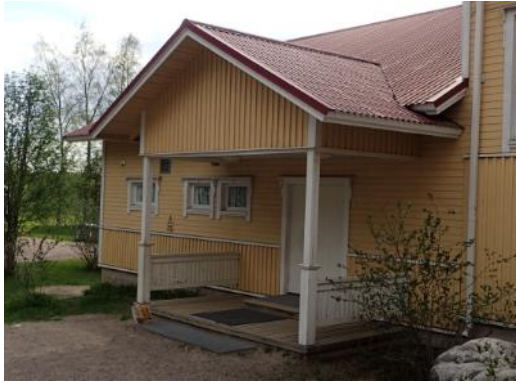
Kuva 40. Monitoimitalon sisäänkäynnin katos
