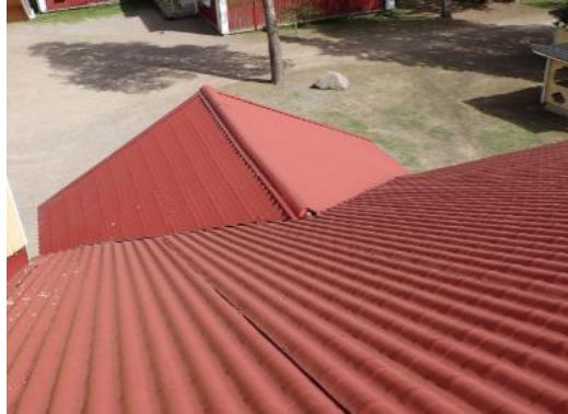
Kuva 45. Yleiskuva lisärakennuksen vesikatolta
