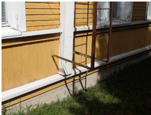
Kuva 61. Talotikkaiden alapäässä ei nousuestettä
