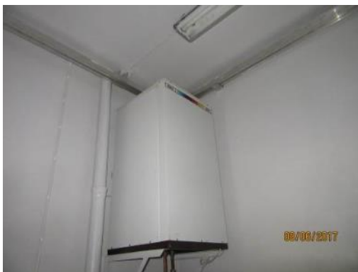
Kuva 95. Lämminvesivaraaja
