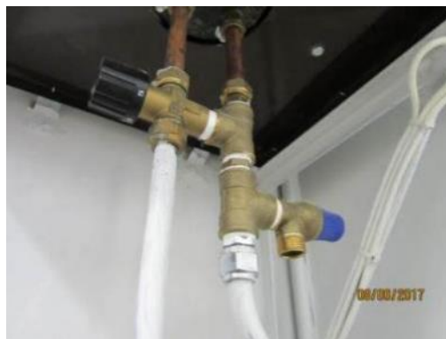
Kuva 96. Lämminvesivaraajan varoventtiili
