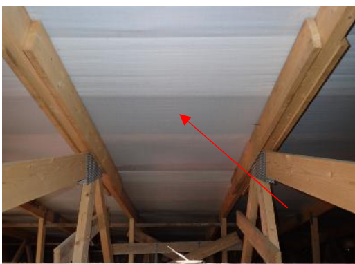
Kuva 48. Aluskate tulisi roikkua kattotuolien välissä
