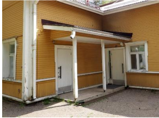
Kuva 41. Keltaisen rakennuksen sisäänkäyntien katos
