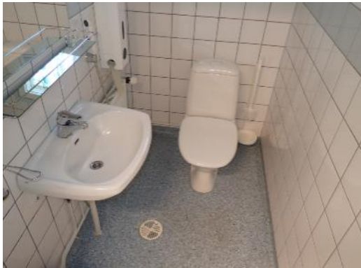
Kuva 72. Yleiskuva monitoimitalon wc-tilasta
