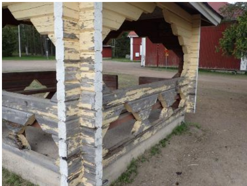
Kuva 18. Hirsikatoksen maalipinta huonossa kunnossa
