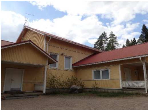
Kuva 24. Yleiskuva monitoimitalon julkisivusta
