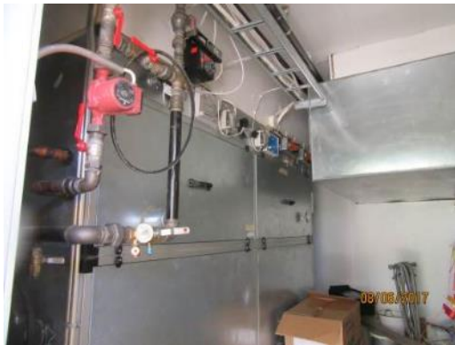
Kuva 57. Monitoimitalon ilmanvaihtokone
