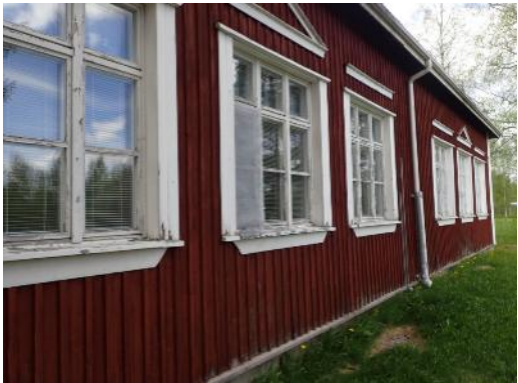
Kuva 30. Yleiskuuvaa punaisen rakennuksen julkisivusta
