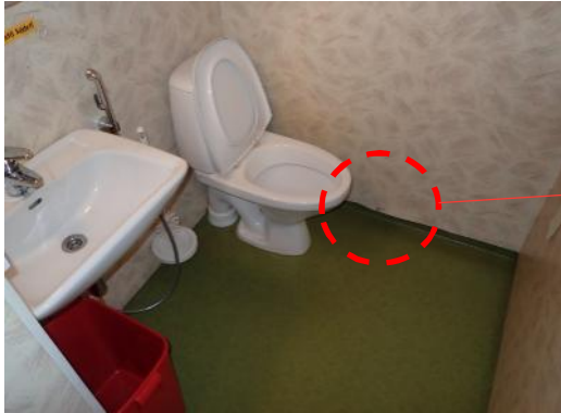
Kuva 70. Yleiskuva punaisen rakennuksen wc-tilasta
