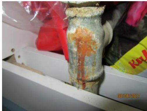
Kuva 94. Galvanoitu T-haara
