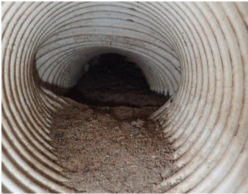
Kuva 15. Salaojaputkessa hiekkaa
