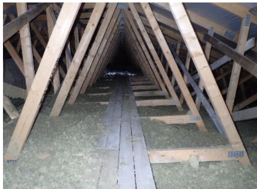
Kuva 47. Yleiskuva monitoimitalon yläpohjasta
