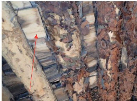
Kuva 53. Vesikatteen alla vanha pärekatto
