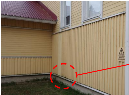
Kuva 26. Uusittuja julkisivulaudoituksia, rännikourut puuttuvat
