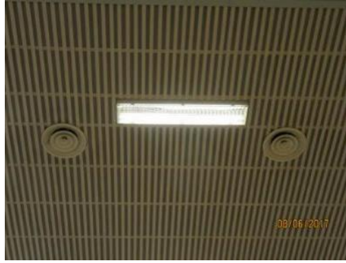
Kuva 62. Liikuntasalin tuloilmaventtiilit
