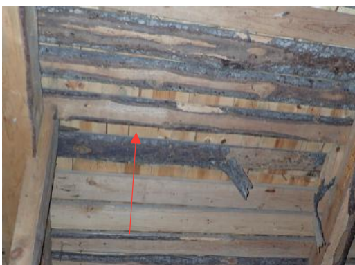
Kuva 60. Peltikatteen alla vanha pärekatto
