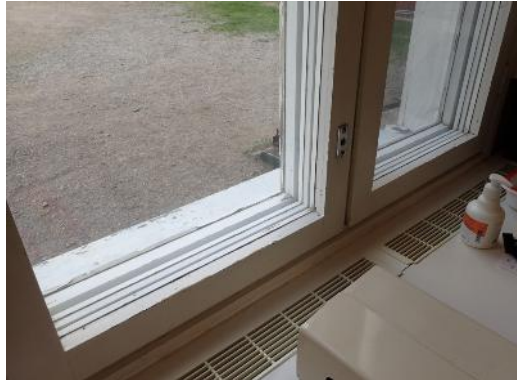
Kuva 33. Kolmipuitteinen puuikkuna
