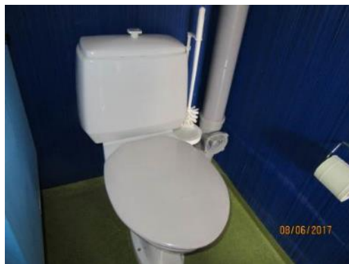
Kuva 98. Viemärikalusteet ovat kunnossa
