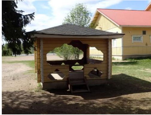
Kuva 17. Hirsirunkoinen katos
