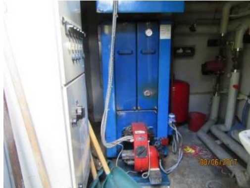
Kuva 84. Lämmityskattila
