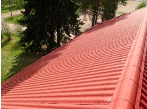
Kuva 56. Yleiskuva punaisen rakennuksen vesikatteesta
