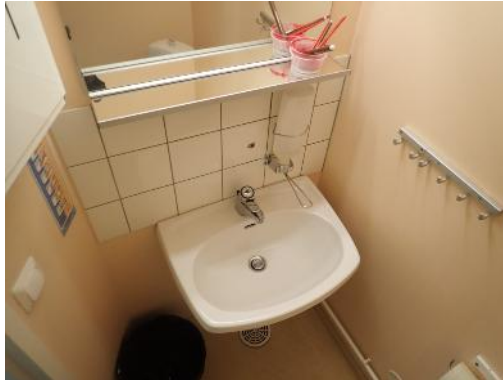
Kuva 69. Yleiskuva lisärakennuksen wc-tilasta
