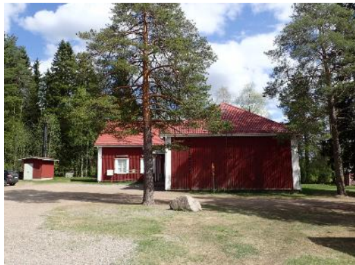
Kuva 2. Yleiskuva piha-alueelta, nurmialueet paikoin huonossa kunnossa
