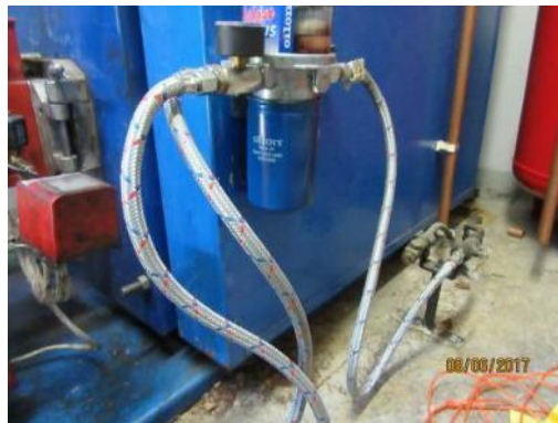
Kuva 86. Öljysuodatin
