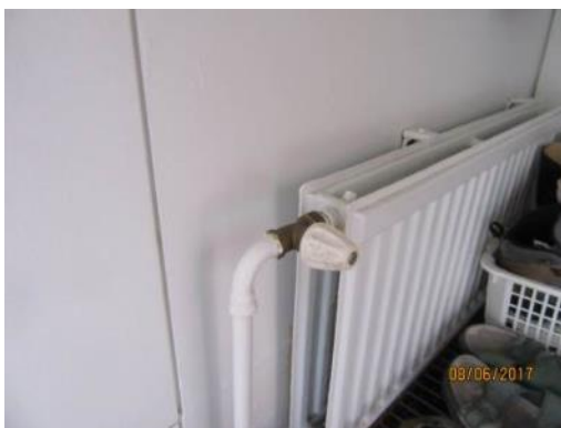
Kuva 91. Patteriventtiili
