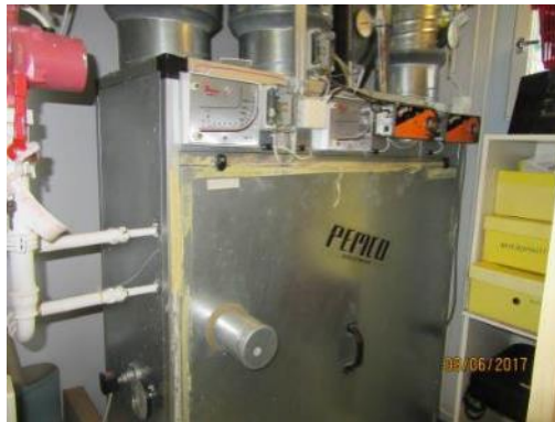
Kuva 58. Monitoimitalon ilmanvaihtokone
