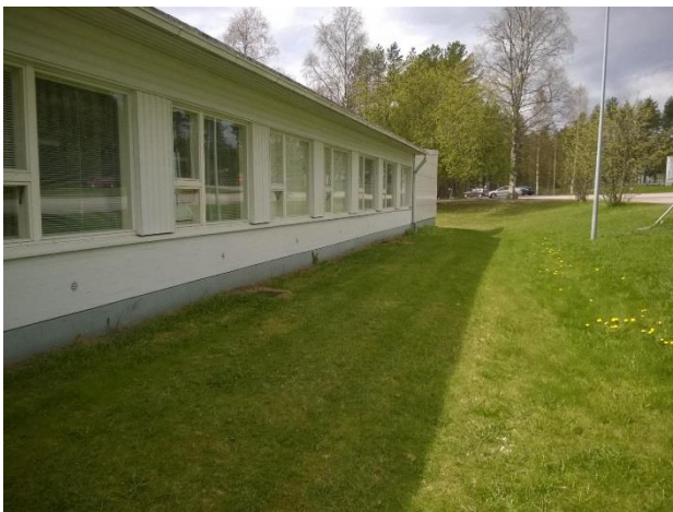
Kuva 1. Kuva rakennuksen pohjoissivulta. Maanpinta viettää rakennukseen päin.
