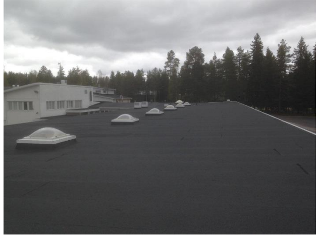
Kuva 6. Kuva itäsiiven osalta. Vesikattorakenteet on uusittu vuonna 1995.
