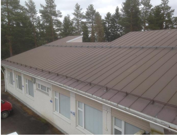
Kuva 5. Lukion osalla vesikatteena on rivipeltikate.
