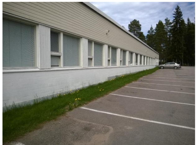
Kuva 2. Kuva rakennuksen itäisivulta. Nurmialueet ovat vasten sokkelirakennetta..
