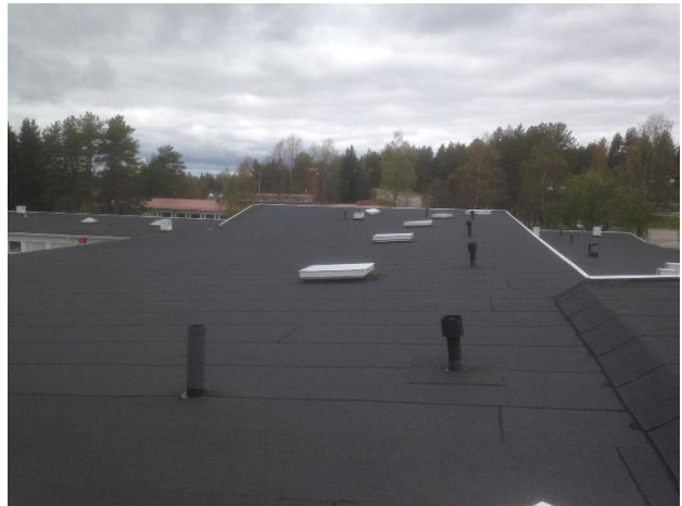
Kuva 8. Kuva pohjoissiiven osalta. Vesikate on uusittu vuonna 1995.
