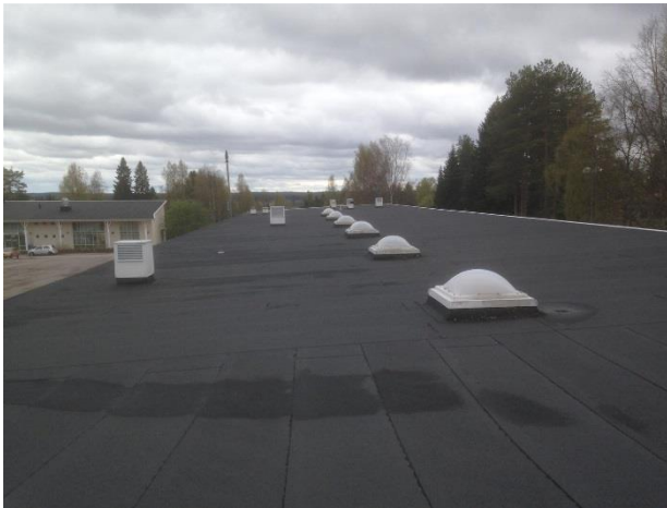
Kuva 7. Kuva länsisiiven osalta. Vesikattorakenteet on uusittu vuonna 1995.
