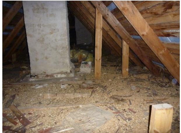
Kuva 83. Yleiskuva yläpohja / ullakkotilasta
