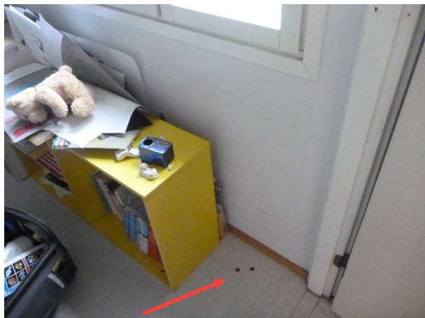
Kuva 12. Rakenneavaus RA4 lattiaraketeeseen ulkoseinänvierelle tehtiin luokkatilan 114 varastoon.
