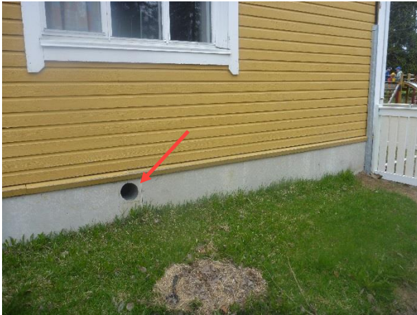
Kuva 46. Alapohjarakenteen ryömintätila tarkastettiin silmämääräisesti tuuletusluukkujen kautta.
