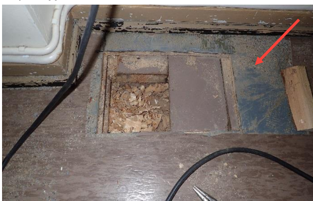
Kuva 56. RA8. Ruskean muovimaton alla vanha sininenmuovimatto, joka on liimattu mustalla liimalla (sis. asbestia).
