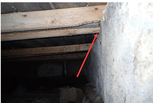
Kuva 50. Alapohjan kannatinhirret luonnonkiviperustuksen päällä.
