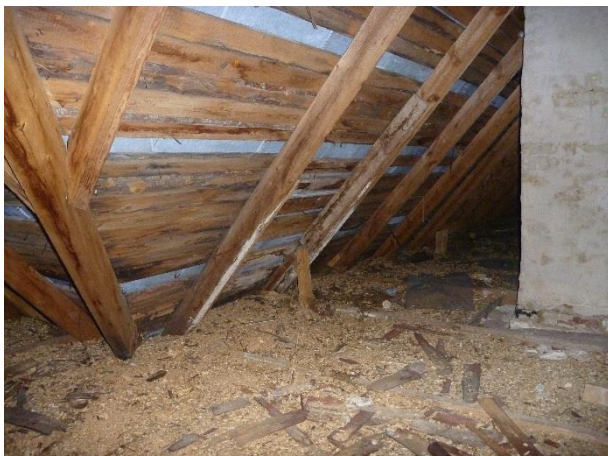
Kuva 84. Yleiskuva yläpohja / ullakkotilasta
