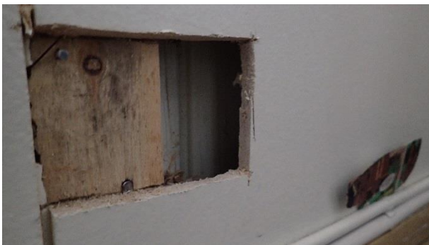
Kuva 74. RA9. Hirsirungon sisäpuolella puukoolaus ja lastulevy. Pahvia ei havaittu.
