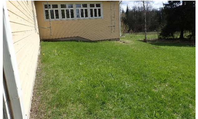
Kuva 2. Kuva lisärakennuksen takasivulta. Piha-alueen kallistus on hyvä. Rakennuksen vierustat ovat nurmipintaiset.
