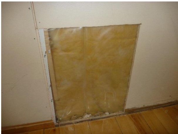
Kuva 18. RA2. Sisäverhouslevyn takana on höyrynsulkumuovi.
