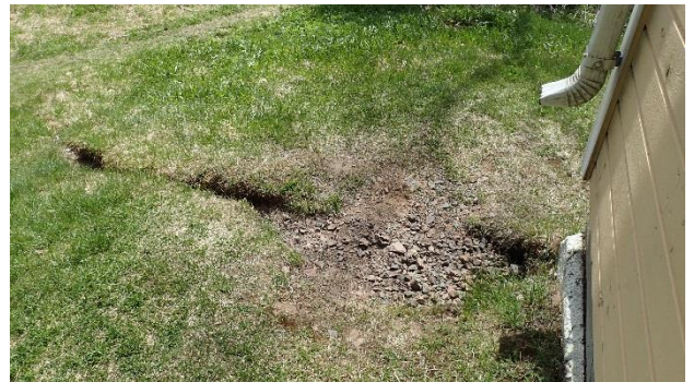
Kuva 4. Sadevedet on ohjattu rakennuksen vierelle. Vesi on kuljettanut maata pois syöksyputken alta.
