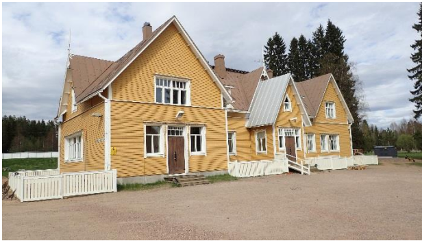
Kuva 40. Kuva rakennuksen etusivulta. Piha-alueen kallistus on loiva rakennuksesta pois päin.
