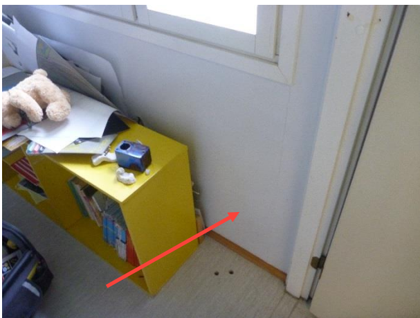
Kuva 24. Rakennereparaus RA3 tehtiin ikkunan alapuolelle varastotilaan.
