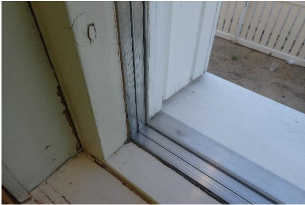
Kuva 78. Osin ikkunat ovat uusittu lämpöikkunoiksi.
