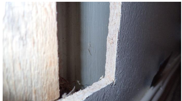
Kuva 75. RA9. Hirsirungon ja koolauksen välissä panelointi.
