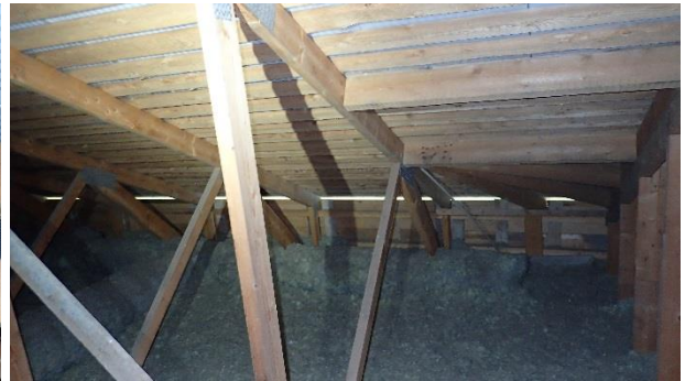
Kuva 30. Yläpohjan eristeenä on puhallusvilla.
