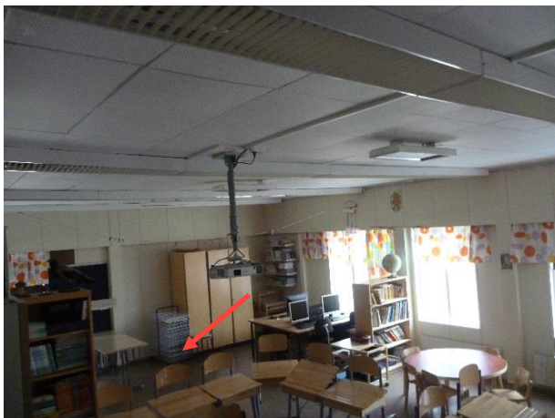
Kuva 54. Alapohjarakenteen rakenneavaus tehtiin opetustilan 3 lattiaan, rakennuksen itäpäätyyn.
