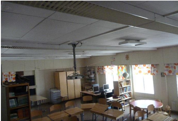
Kuva 72. Rakenneavaus RA9 ulkoseinän sisäpuolelle tehtiin opetustilaan 3.
