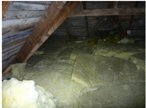
Kuva 87. Teknisen työn luokan kohdalla lämmöneristeenä on mineraalivilla.
