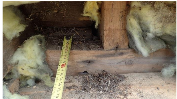
Kuva 65. RA6. Hirsirunkoa vasten puukoolaus ja mineraalivilla 50 mm. Villassa on tummentumia.
