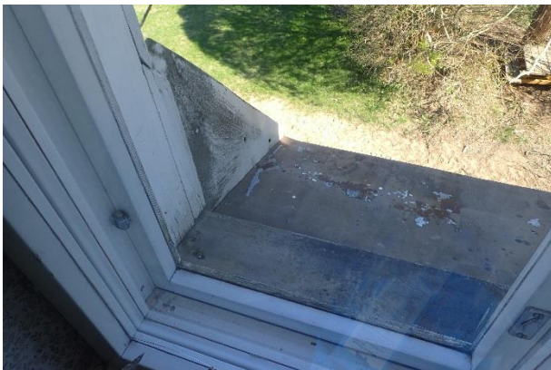
Kuva 80. Osin ikkuvat ovat kolmilasiset.
