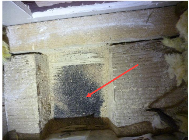
Kuva 21. RA2. Alaohjauspuun alla on bitumikermikaista.
