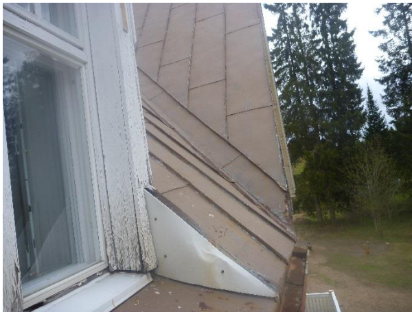
Kuva 88. Rakennuksen vesikatteena on konesaumattupelti.
