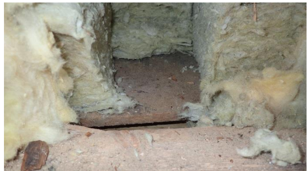
Kuva 71. RA7. Lattiaeristeen alla on tuulensuojalevy.
