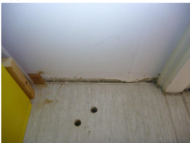
Kuva 13. RA4. Rakenne tarkastettiin porauksella.
