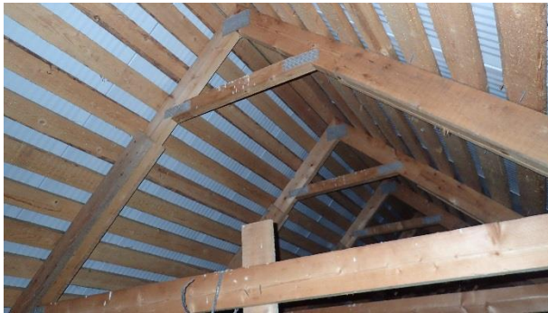
Kuva 29. Yleiskuva yläpohjatilasta. Kattorakenteet ovat hyvässä kunnossa. Vesikatteen alla ei ole aluskatetta.
