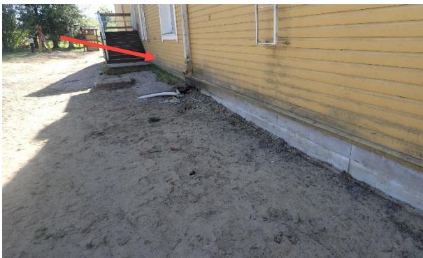
Kuva 60. Rakenneavaus RA7 tehtiin ulkoseinän alaosaan keittiön kohdalle, josta myös alapohjarakenne tarkastettiin.
