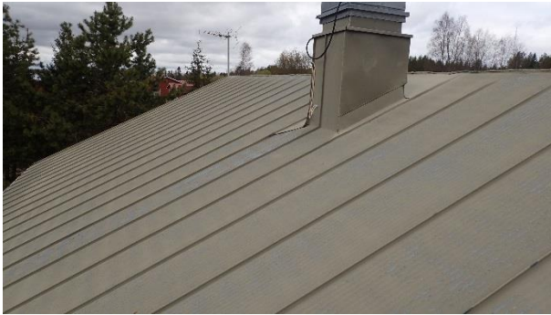
Kuva 35. Yleiskuva vesikatteesta. Vesikateena on konesaumattu peltikate.
