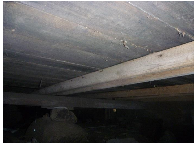
Kuva 49. Alapohjan alapinnalla ei havaittu merkittäviä vaurioita tarkastusten kohdalla.
