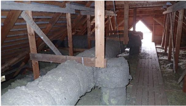
Kuva 31. Yläpohjaan on asennettu kulkutasot.
