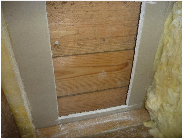
Kuva 20. RA2. Tuulensuojalevy on kipsilevyä. Levyn takana ilmarako ja ulkoverhous.
