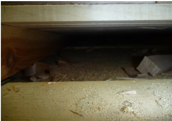
Kuva 9. RA1. Lattialaudoituksen alla on tuuletusväli
