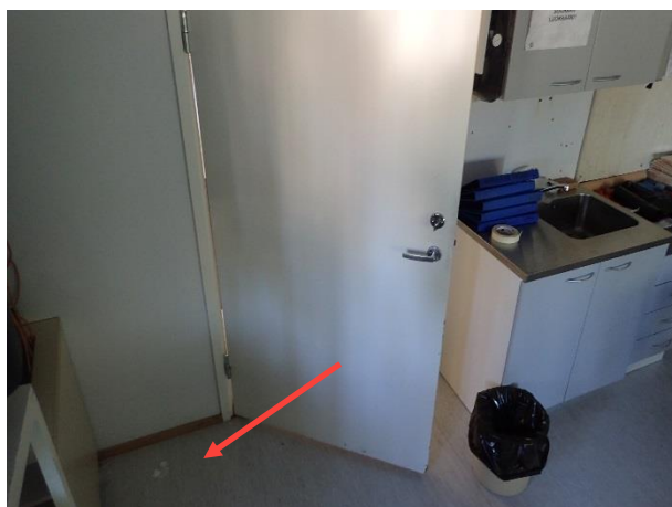
Kuva 14. Rakenneavaus lattiarakenteen keskialueelle tehtiin luokkatilan 114 lattiaan väliseinän vierelle.
