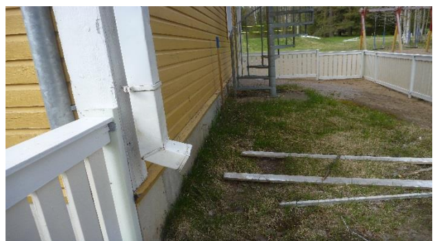
Kuva 45. Kuva rakennuksen päädyssä. Rakennuksen vierellä maanpinta nurmipintainen
