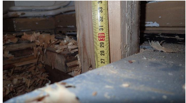
Kuva 59. RA8. Lattiarakenteen paksuus noin 280 mm + lattian kannatinhirret ja alapinnan laudoitus.
