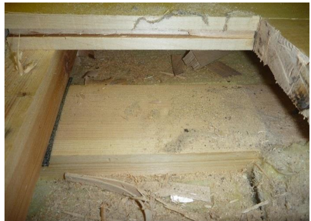
Kuva 8. RA1. Puurakenteet ovat hyväkuntoiset
