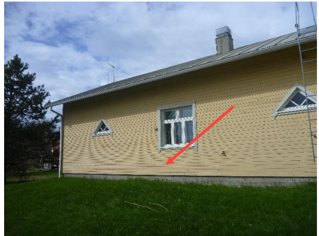
Kuva 23. Rakennereparatuksen RA3 kohta ulkopuolelta kuvattuna.
