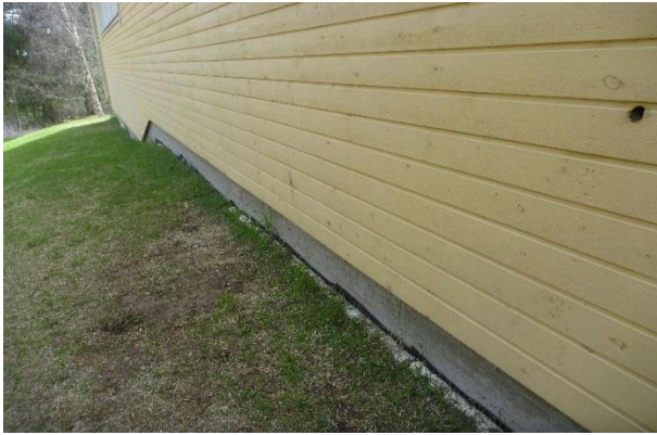
Kuva 26. Julkisivupanelointi on yleisesti hyvä kuntoinen.
