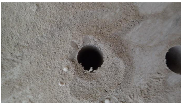
Kuva 15. RA5. Rakenne tarkastettiin porauksella.
