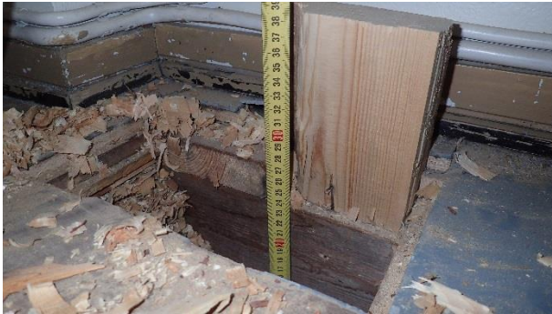
Kuva 58. RA8. Alapohjaeristettä on noin 240 mm. Muovimatot on asennettu lastulevyn päälle jonka alla alkuperäinen ponttilaudoitus.
