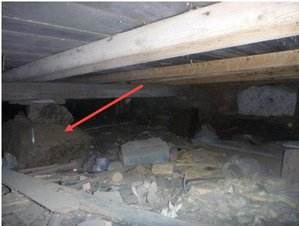
Kuva 48. Kuva alapohjan ryömintätilasta. Alapohja tukeutuu luonnonkivien varaan.
