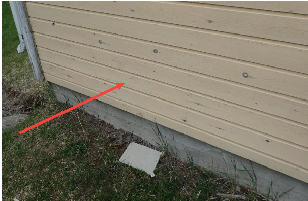
Kuva 16. Rakenneavaus RA2. Kuva rakenneavauksen kohdalta rakennuksen ulkopuolelta.
