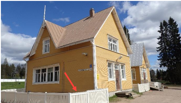
Kuva 62. Rakenneavaus RA6 tehtiin ulkoseinään, rakennuksen länsipäättyyn.
