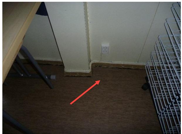
Kuva 55. Rakenneavaus tehtiin ulkoseinän vierelle.
