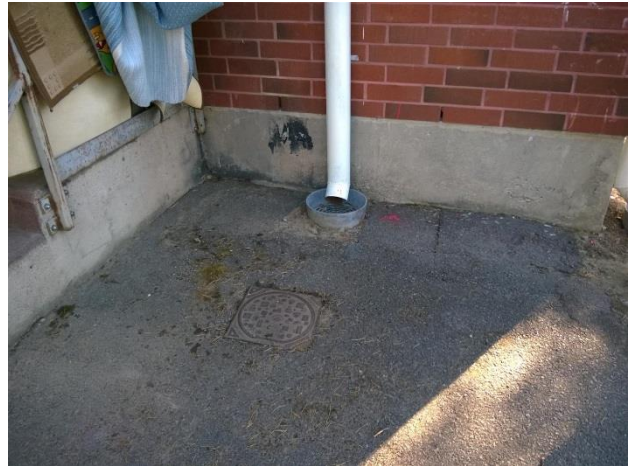
Kuva 4. Vesikaton sadevedet on ohjattu räystäskourujen ja syöksyputkien avulla sadevesikaivoihin.
