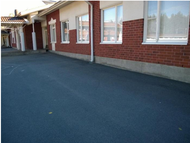
Kuva 3. Kuva rakennuksen takasivulta. Maanpinta on noin 30...40 senttimetriä valmiin lattiapinnan alapuolella.
