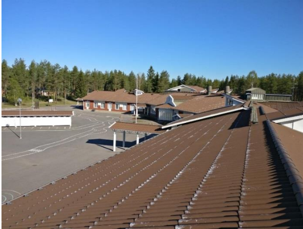
Kuva 5. Vesikatteena on käytetty kuitusementtikatetta.
