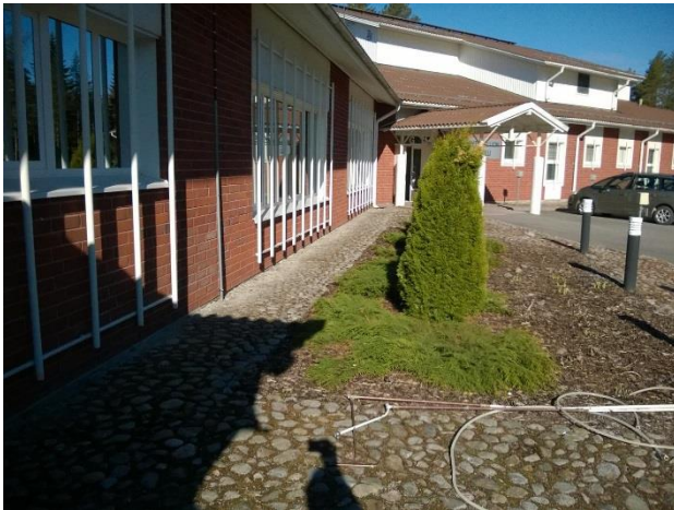
Kuva 1. Kuva rakennuksen etusivulta. Maanpinnan korkeusasema on lähes rakennuksen valmiin lattiapinnan tasolla.
