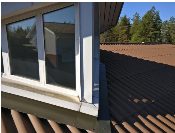
Kuva 9. Rakennuksen vesikatonle on asennettu kattoikkunoita.
