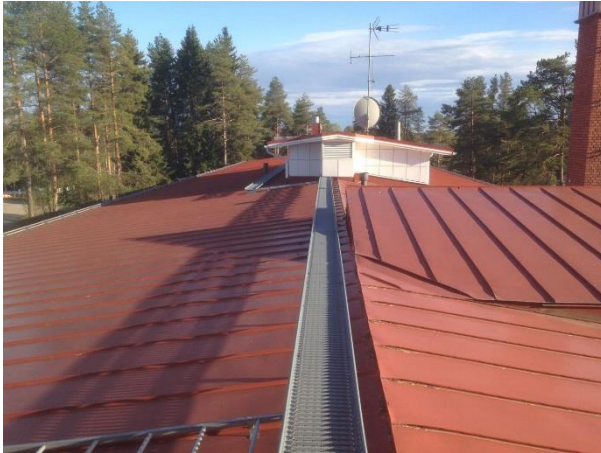
Kuva 5. Vesikatteena on rivisaumattu peltikate.
