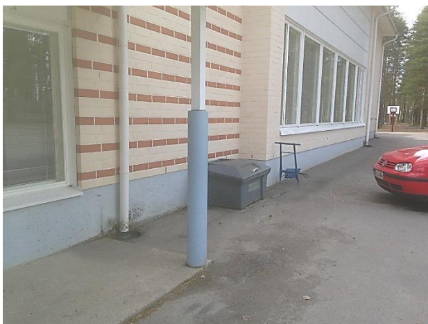
Kuva 1. Kuva rakennuksen etusivulta. Maanpinta viettää loivasti rakennuksesta poispäin.
