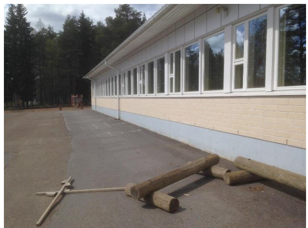
Kuva 2. Kuva rakennuksen takasivulta. Maanpinta viettää loivasti rakennuksesta poispäin.
