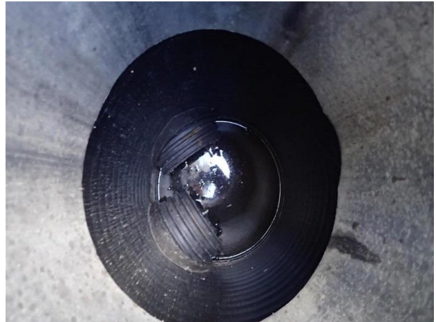
Kuva 4. Salaojajärjestelmän tarkastuskaivoista tehtyjen havaintojen perusteella salaojajärjestelmän toiminnassa ei havaittu puutteita.
