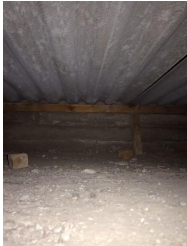
Kuva 8. Tarkastusaukkojen kautta kuvattuna yläpohjan ilmatilaa.
