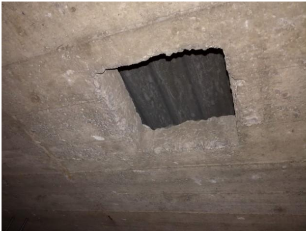
Kuva 7. Kiinteistön sisätiloissa suoritetun sisäkattotarkastuksen yhteydessä havaittiin tarkastusaukkoja yläpohjarakenteeseen.
