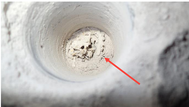
Kuva 34. RA9. Betonilaatan alla tojalex-levy
