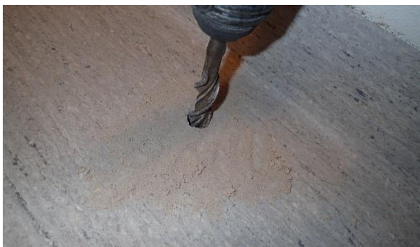
Kuva 16. RA6. Lattiarakenne tarkastettiin porauksella.
