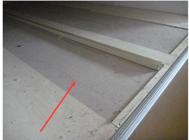
Kuva 43. Rakenneavaus (RA8) liikuntasalin lattiaan tehtiin näyttämön alle.
