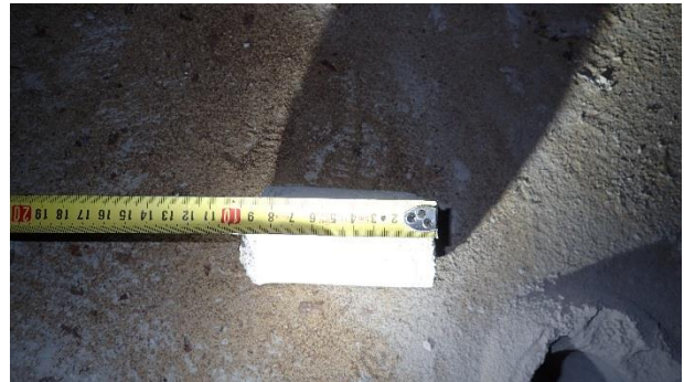
Kuva 33. RA9. Yläpohjan palopermannon betonin paksuus on noin 100 mm.
