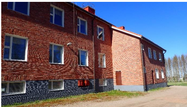
Kuva 1. Kuva rakennuksen takasivulta. Piha-alueen kallistus on loivasti rakennuksesta poispäin.
