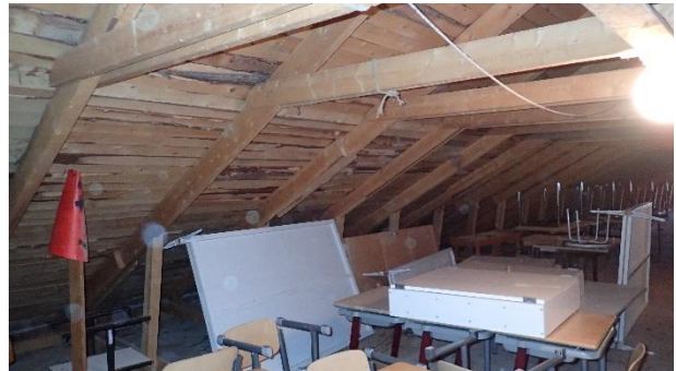
Kuva 29. Yleiskuva yläpohja / ullakkotilasta. Ullakkotilassa mm. pulpetteja ja tuoleja.
