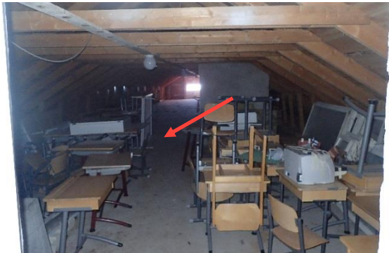
Kuva 32. Rakenneavaus RA9 yläpohjaan tehtiin ullakkotilan puolelta rakennuksen keskeltä.
