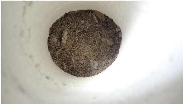
Kuva 39. RA3. Lattiabetonin alla ilmatila ja painotäytteenä hiekkaa.
