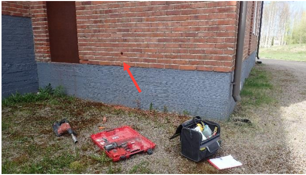
Kuva 22. RA2. Ulkoseinärakennearaus maanpinnan yläpuolelta, rakennuksen takasivulta.
