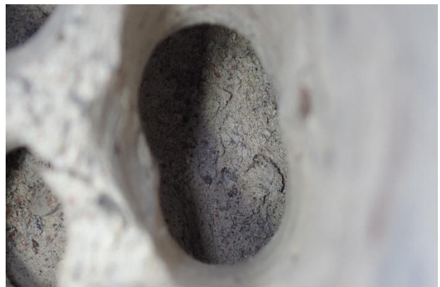
Kuva 13. RA4. Betonilaatan alla ilmatila ja täyttöhiekka.
