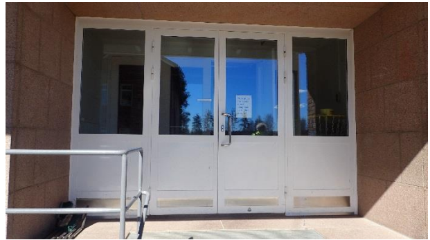
Kuva 27. Rakennuksen pääovet ovat metallirakenteiset.
