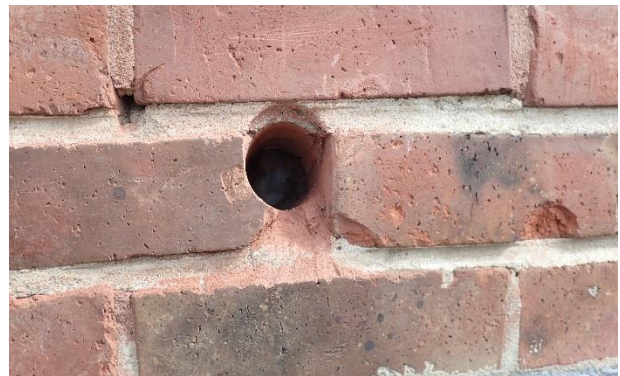
Kuva 19. RA1. Rakenneavaus tehtiin porauksella.
