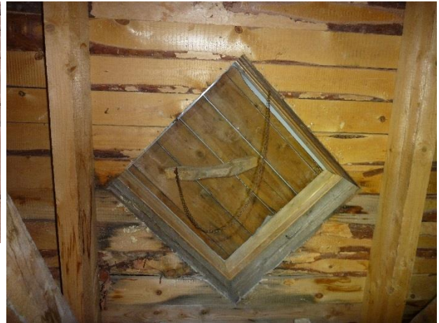
Kuva 51. Kulkuluukku vesikaton yläpohjatilassa
