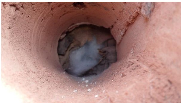
Kuva 20. RA1. Ulkoverhoustiilen takana lämmöneristeenä pitkäkuituinen mineraalivilla.
