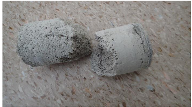
Kuva 38. RA3. Kuva lattiarakenteen betonista.
