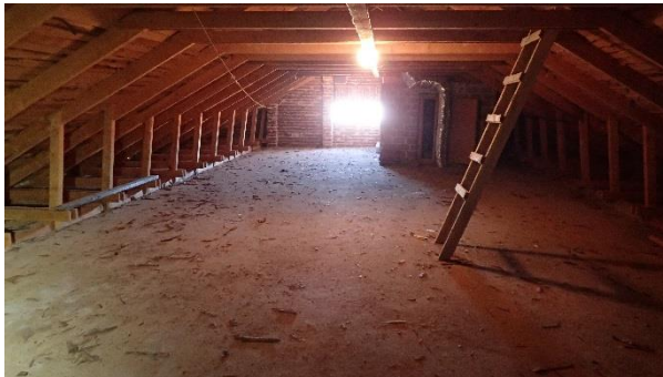
Kuva 28. Yleiskuva yläpohja / ullakkotilasta
