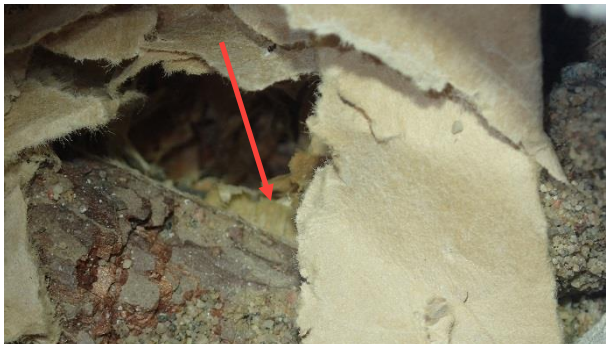
Kuva 41. RA3. Äänieristeenä välipohjassa on kutterinlastua noin 120mm.
