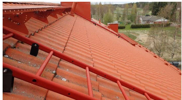
Kuva 47. Yleiskuva vesikatosta. Vesikatto on hyväkuntoinen. Vesikatolla on asianmukaiset lapetikkaat sekä kulkusillat.
