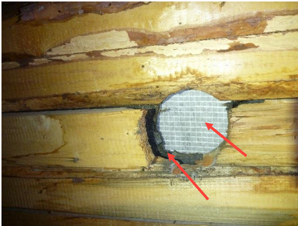
Kuva 52. Vanha läpivienti aukko vesikaton aluslaudoituksessa. Kuvassa vanhaa bitumikermiä sekä uusittu muovinen aluskate.
