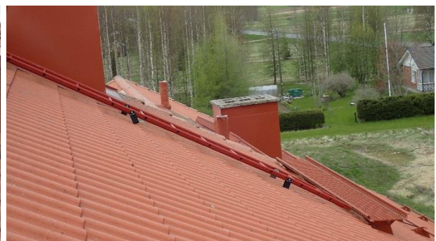
Kuva 49. Vesikatto on hyväkuntoinen. Vesikatolla on asianmukaiset lapetikkaat sekä kulkusillat.
