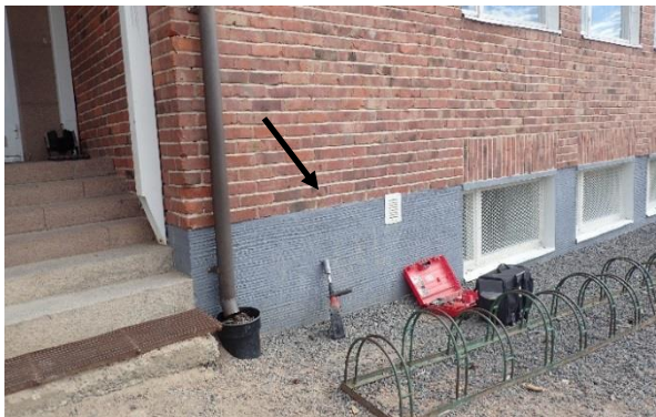
Kuva 18. RA1. Ulkoseinän rakenneavauksen kohta maanpinnan yläpuolelta, liikuntasalin kohdalla, rakennuksen etusivulla.
