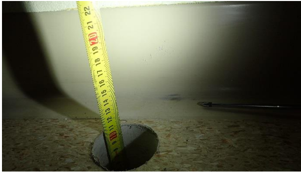
Kuva 37. RA3. Pintalaatan vahvuus noin 110mm.
