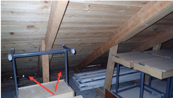
Kuva 30. Vesikattorakenteet ovat yleisesti hyvässä kunnossa ullakkotilassa. Ullakkotilan tuuletus räystäältä on estynyt.
