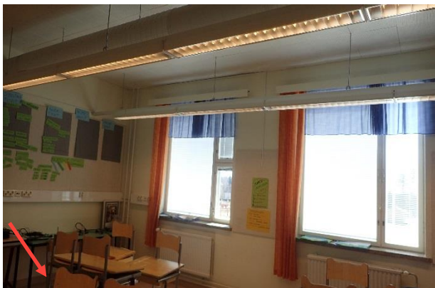
Kuva 35. Yleiskuva luokka 3. Rakenneavaus RA3 väliseinänvierelle.
