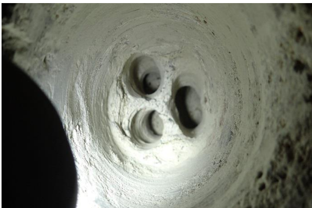
Kuva 12. RA4. Kuva lattiarakenteen betonista.
