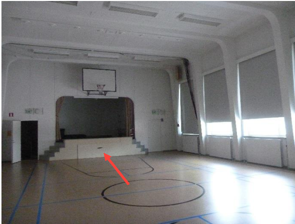
Kuva 42. Rakenneavaus (RA8) liikuntasalin lattiaan tehtiin näyttämön alle.
