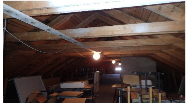
Kuva 31. Vesikattorakenteet ovat yleisesti hyvässä kunnossa ullakkotilassa
