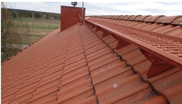
Kuva 46. Yleiskuva vesikatosta. Vesikatto on hyväkuntoinen. Vesikatolla on asianmukaiset kulkusillat.
