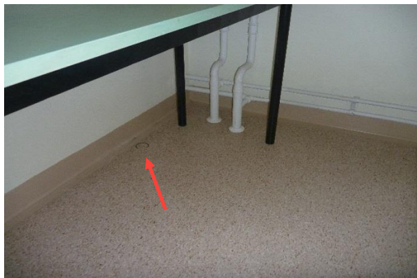
Kuva 36. Välipohjan rakenneavaus RA3.
