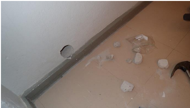
Kuva 24. RA7. Rakennearaus maanpinnan alapuolelta teknisentyöluokan ulkoseinään lattiapinnan yläpuolella.
