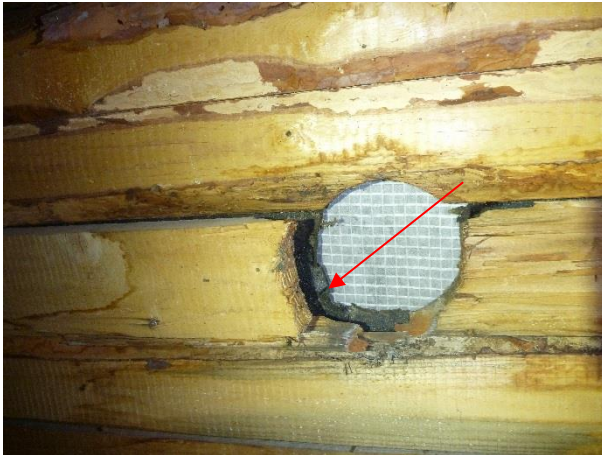
Kuva 53. Vesikaton vanha bitumikermi sisältää asbestia antofylliitti.
