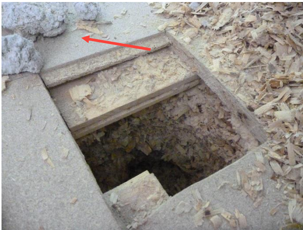
Kuva 44. RA8. Äänieristeenä välipohjassa on sahanpurua ja kutterinlastua. Eristettä on yhteensä noin 490mm. Eristeen alla on betonilaatta. Betonivalun palasia oli irrallaan eristeen sisässä.
