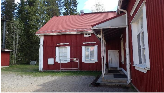
Kuva 74. Rakennuksen vierellä maanpinta on tasainen.
