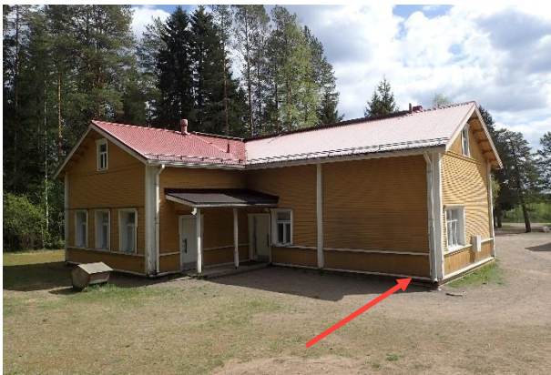
Kuva 42. Rakenneavaus RA4 tehtiin rakennuksen takasivulle.
