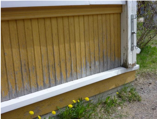
Kuva 34. Rakennuksen perustus on lähellä maanpintaa.
