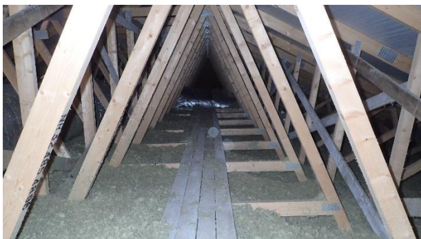
Kuva 26. Yleiskuva yläpohjasta. Eristeenä on puhallusvilla. Puurakenteet ovat hyväkuntoiset.
