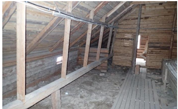
Kuva 109. Yleiskuva yläpohja / ullakkotilasta
