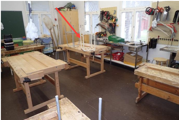
Kuva 52. Rakenneavaus RA7 tehtiin teknisentyön luokkaan.
