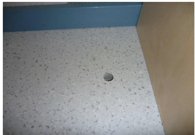
Kuva 37. RA5. Lattiarakenne tarkastettiin porauksella.
