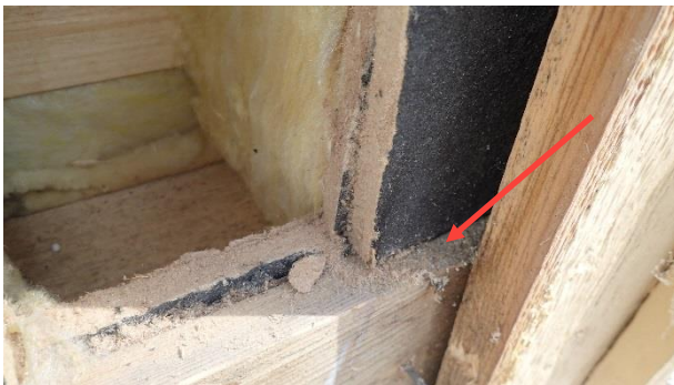
Kuva 16. RA1. Lomalaudoituksen takana on vaakakoolaus.
