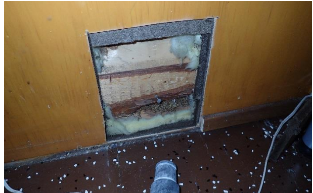
Kuva 92. RA11. Sisäpuolen koolaukseen on asennettu mineraalivilla.
