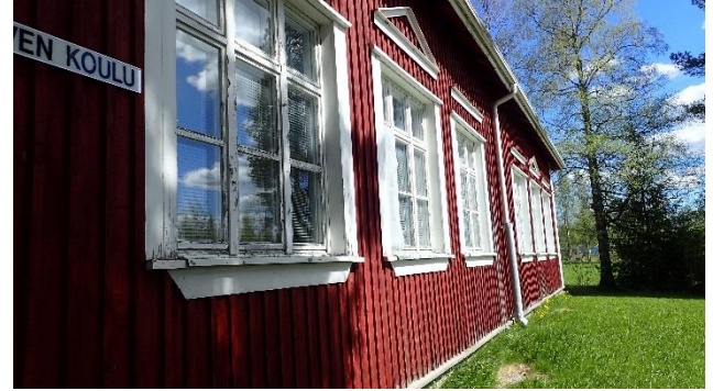
Kuva 75. Rakennuksen vierellä maanpinta on tasainen.
