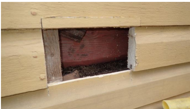
Kuva 48. RA6. Vaakapaneloinnin takana pystykoolaus. Hirsirungon pinnalla ei havaittu näkyviä vaurioita.
