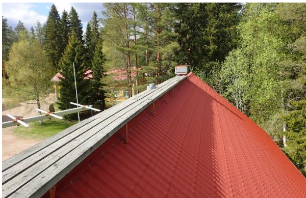
Kuva 116. Harjalle on asennettu puurakenteinen kattosilta.
