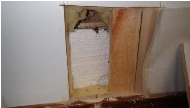
Kuva 54. RA7. Sisäverhouslevyn takana on höyrynsulkumuovi. EPS-solumuovi eriste ulottuu noin 20 cm korkeudelle lattian yläpinnasta.
