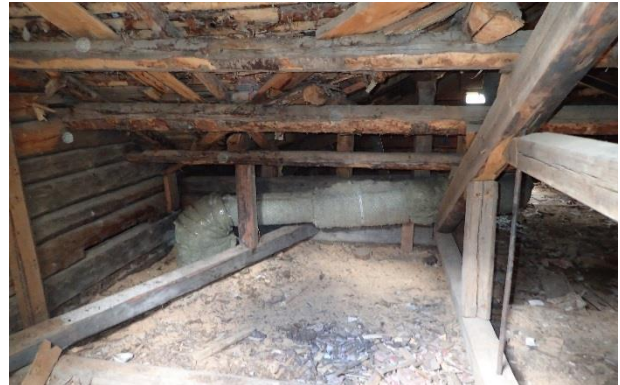
Kuva 66. Yleiskuva yläpohja / ullakkotilasta
