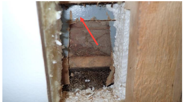
Kuva 55. Hirren pinnalla on vanha sisäverhouslevy, kovalevy.
