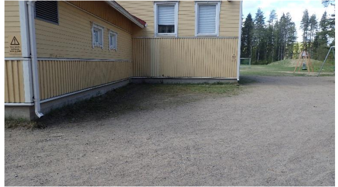
Kuva 2. Kuva rakennuksen päädyistä. Piha-alueen kallistus on loiva rakennuksesta poispäin.
