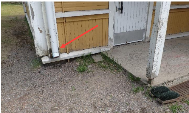
Kuva 32. Sadevedet on ohjattu rakennuksen vierelle.
