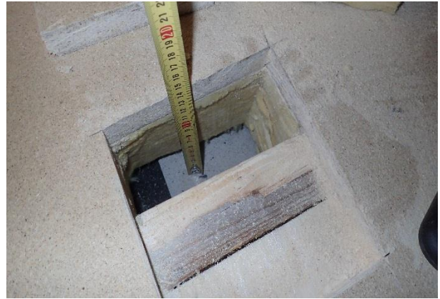
Kuva 7. RA2. Puurakenteet ovat hyväkuntoiset.
