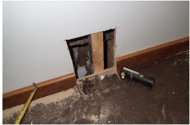
Kuva 62. RA10. Kuva rakenneavauksesta.
