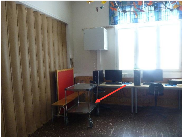
Kuva 78. Rakenneavaus RA12 tehtiin luokkatilan lattiaan ulkoseinän vierelle.
