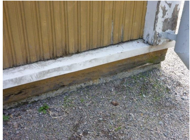
Kuva 35. Rakennuksen perustus on lähellä maanpintaa.
