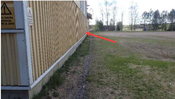
Kuva 12. Rakenneavaus RA1. Kuva rakenneavauksen kohdalta rakennuksen ulkopuolelta.
