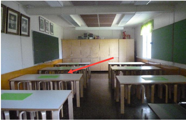
Kuva 103. Rakenneavaus RA14. Rakenneavaus kantavaan väliseinään tehtiin lattian rajaon ruokasaliin.
