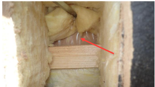
Kuva 15. RA1. Sisäverhouslevyn ja puukoolauksen välissä on höyrynsulkumuovi.
