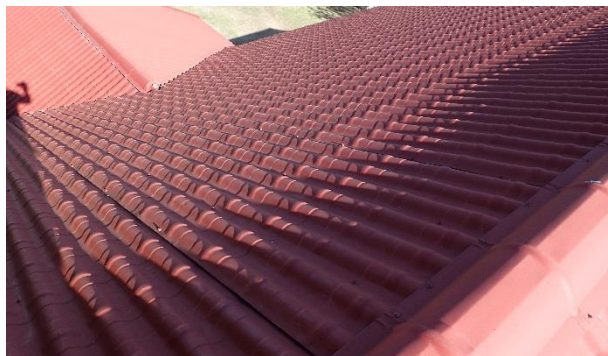
Kuva 23. Vesikatteen pinta on hyväkuntoinen.
