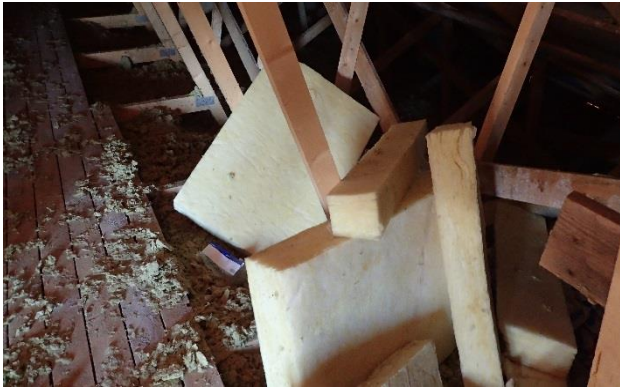
Kuva 28. Yläpohjassa rakennusjätettä.
