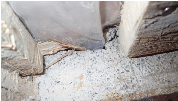
Kuva 107. RA14. Höyrynsulkumuovi on nostettu lattian alta hirsirunkoa vasten.
