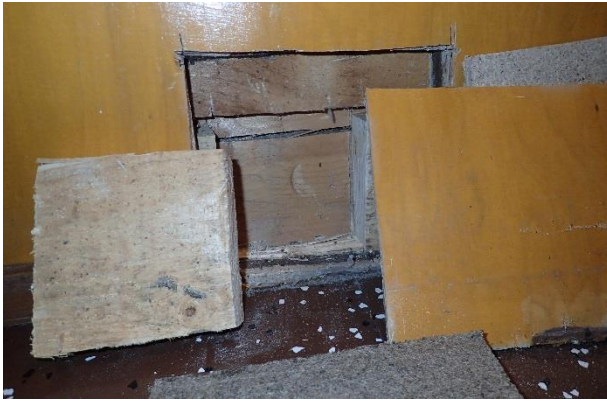
Kuva 85. RA15. Puukuitueristelevyn takana on puukoolaus ja hirsirunko. Mineraalivilla eristettä ei havaittu.
