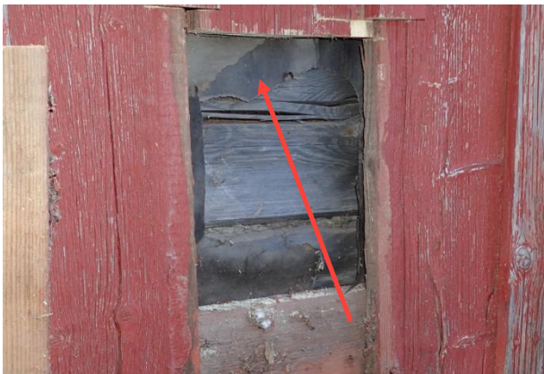
Kuva 95. RA17. Hirren ja puuverhouksen välissä on tuulensuojapaperi.
