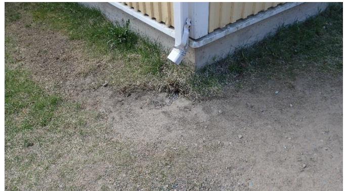
Kuva 4. Sadevedet on ohjattu rakennuksen vierelle rakennuksen etusivulla.
