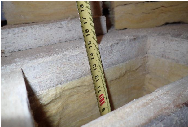
Kuva 8. RA2. Puurakenteiden kokonais paksuus on noin 150 mm.
