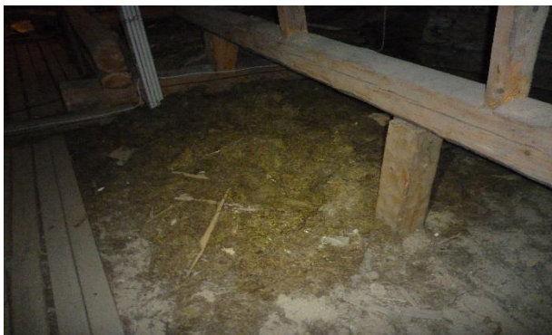
Kuva 110. Yleiskuva yläpohja / ullakkotilasta. Eristeenä on sammalen ja hiekan seos.
