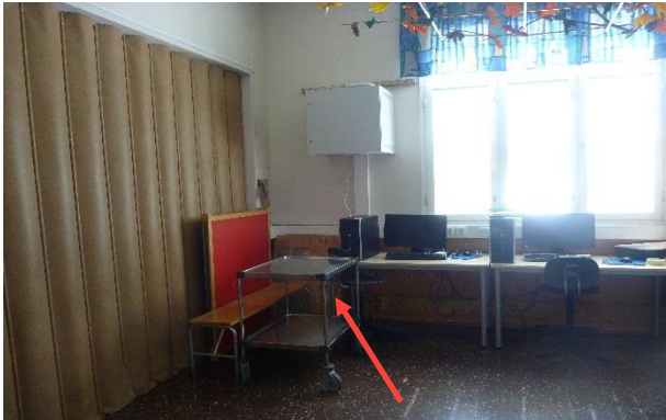
Kuva 91. Rakenneavaus RA11 tehtiin luokkatilan 5-6 ulkoseinään.
