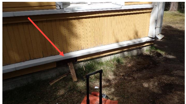
Kuva 49. Rakenneavaus RA9 tehtiin ulkoseinän alaosaan rakennuksen etusivulle.
