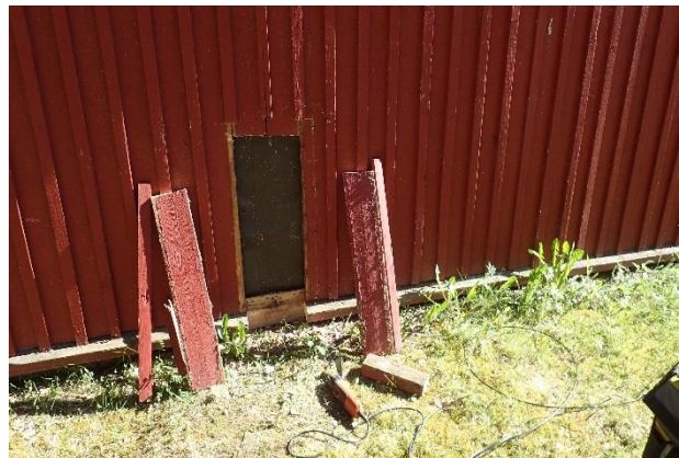
Kuva 96. Rakenneavaus RA18 tehtiin ruokalan kohdalla rakennuksen ulkopuolelle.
