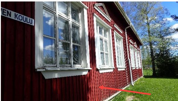
Kuva 93. Rakenneavaus RA17 tehtiin luokan 5-6 kohdalle rakennuksen ulkopuolelle.
