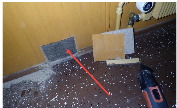
Kuva 84. RA15. Sisäverhouselevyn takana on puukuituinen eristelevy.
