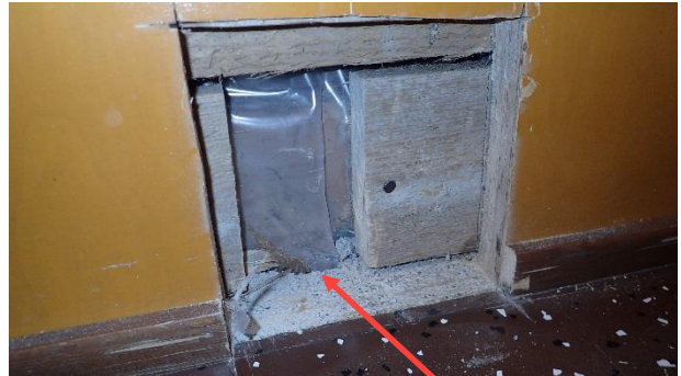
Kuva 106. RA14. Lattiabetoni on valettu hirsirunkoa vasten.
