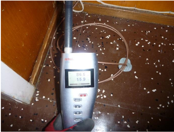
Kuva 80. Suhteellinen kosteus mitattiin rakenneavauksesta täyttöhiekan yläpinnasta.
