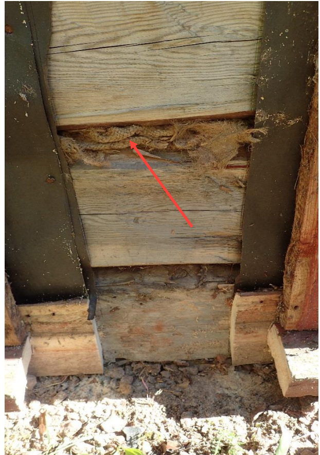
Kuva 98. Hirsirungon tiivistyksenä on mm. juuttikangas.
