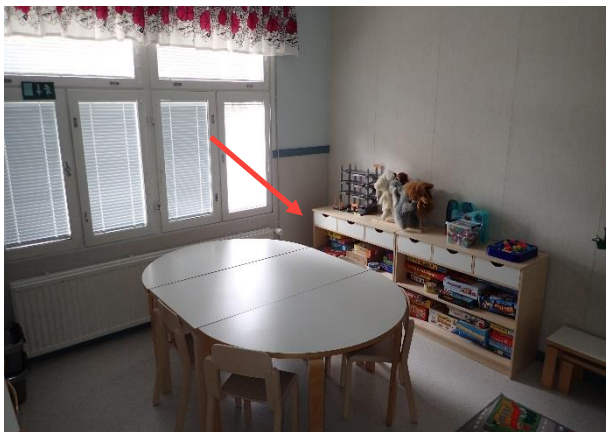
Kuva 36. Rakenneavaus RA5 tehtiin luokkatilan lattiaan ulkoseinän vierelle.
