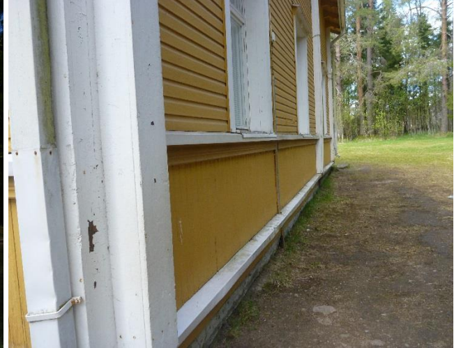
Kuva 31. Rakennuksen vierellä maanpinta on tasainen.
