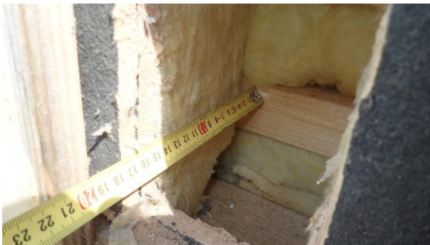
Kuva 14. RA1. Rakenneavauksen kohdalla ei havaittu näkyviä merkkejä kosteudesta tai vaurioista
