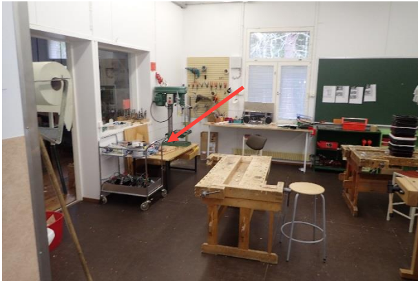
Kuva 61. Rakenneavaus RA10. Rakenneavaus kantavaan väliseinään tehtiin lattian rajaon teknisentyöntilaan.
