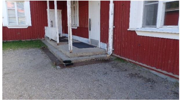
Kuva 102. Rakennuksen ulko-ovet ovat tyydyttävässä kunnossa.
