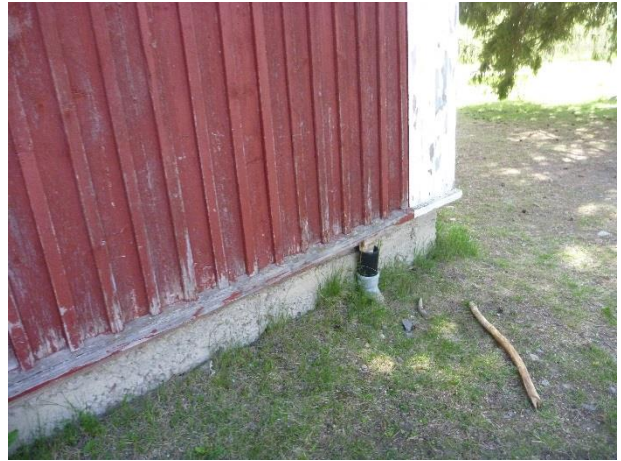
Kuva 81. Tienpuoleisella sivulla maanpinnan yläpuolella näkyvää sokkelirakennetta on noin 250 mm.
