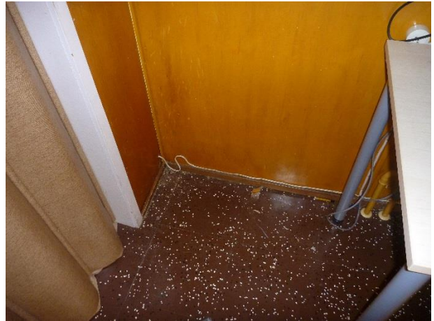
Kuva 79. RA12. Lattiapinnoitteena on muovimatto.
