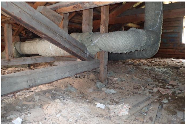
Kuva 67. Yleiskuva yläpohja / ullakkotilasta. Eristeenä on sahanpurun ja hiekan seos.
