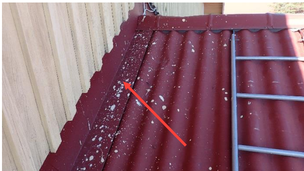
Kuva 24. Seinänostopelti on asianmukainen
