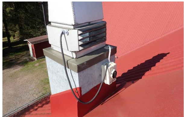
Kuva 115. Läpivienneissä ei havaittu merkittäviä puutteita.
