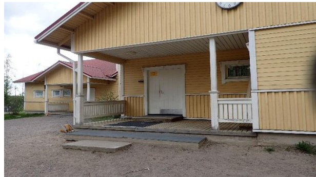
Kuva 21. Ulko-ovet ovat puurakenteiset ja hyväkuntoiset.
