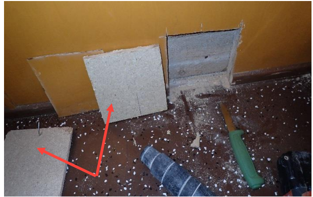
Kuva 104. RA14. Koivuvanerin takana kaksi lastulevyä.
