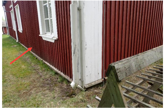
Kuva 86. Rakenneavaus RA 16 tehtiin ruokasalin kohdalle rakennuksen ulkopuolelle.
