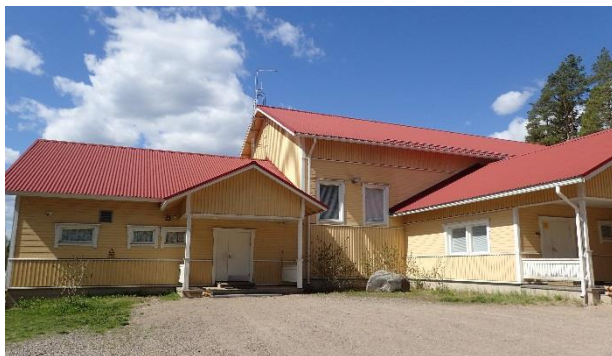
Kuva 22. Yleiskuva vesikatosta. Vesikatolla ei ole lumiesteitä kulkualueiden kohdilla.
