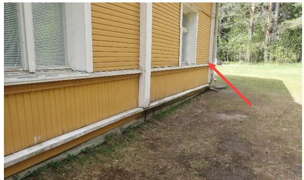
Kuva 47. Rakenneavaus RA6 tehtiin rakennuksen päätyyn ikkunan alareunan tasalle.
