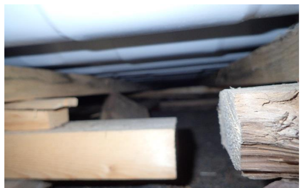
Kuva 70. Peltikate on koolattu pärekatteen päälle puurakenteella.
