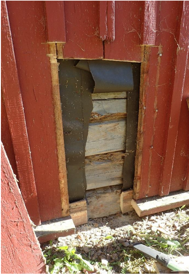
Kuva 97. RA18. Hirsirungon alaosa on maanpinnan tasalla.
