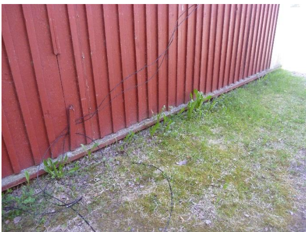
Kuva 82. Rakennuksen perustukset ovat täysin maanpinnan alapuolella piha puolella.
