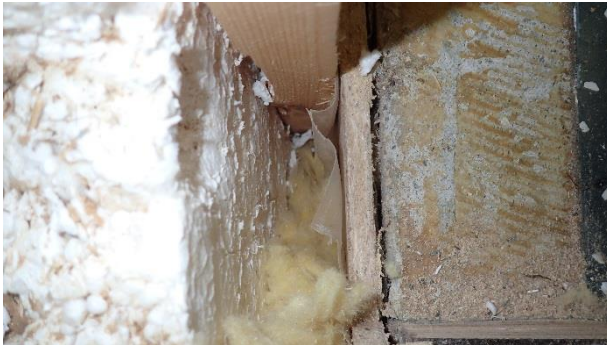
Kuva 56. RA7. Lisäeristys ja sisäverhouslevy ulottuu lattiarakenteen yläpinnan alapuolelle.
