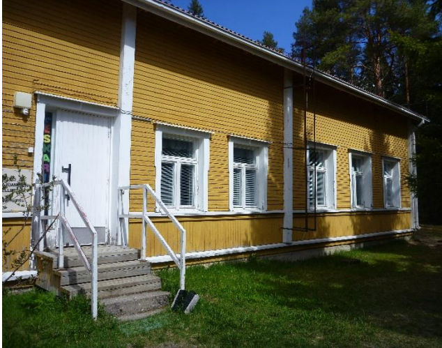
Kuva 30. Rakennuksen vierellä maanpinta on tasainen.
