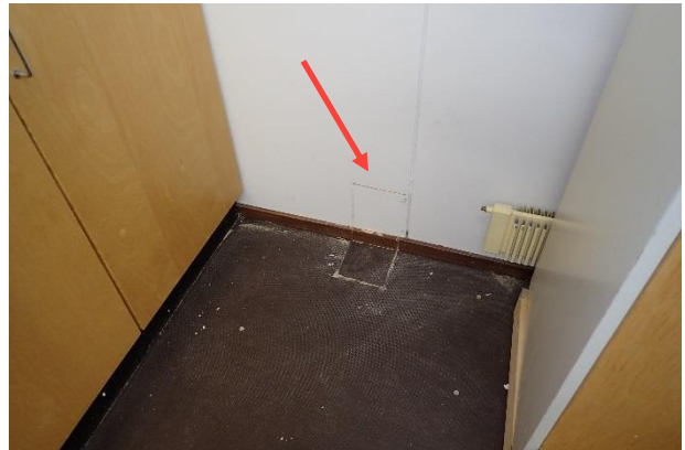
Kuva 53. RA7. Rakenneavaus tehtiin lattian rajaan.
