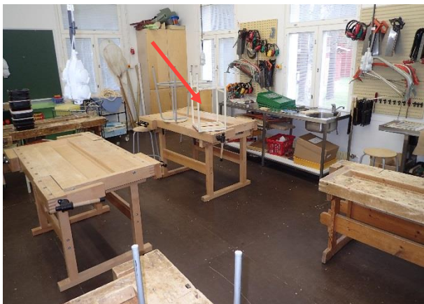
Kuva 38. Rakenneavaus RA7 tehtiin teknisentyötilan lattiaan ulkoseinän vierelle.
