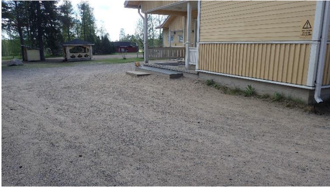
Kuva 1. Kuva rakennuksen etusivulta. Piha-alueen kallistus on loiva rakennuksesta poispäin.
