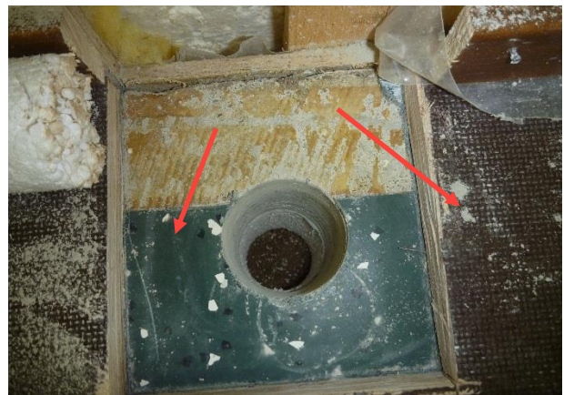
Kuva 39. Betonirakenteen päällä on muovimatto ja filmivaneri.
