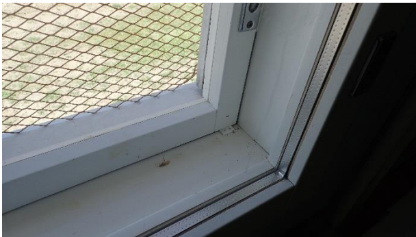
Kuva 20. Ikkunat ovat hyvässä kunnossa. Ulkopuolen puuosille suositellaan huoltomaalausta.
