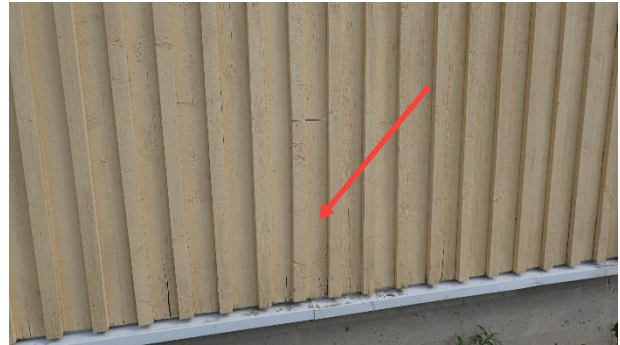
Kuva 13. RA1. Kuva rakenneavauksen kohdasta.
