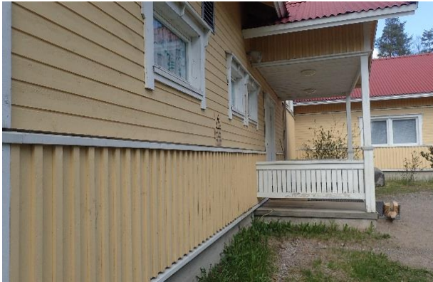
Kuva 18. Pohjoisen ja idän puolen sivuilla julkisivun pinta on hyväkuntoinen
