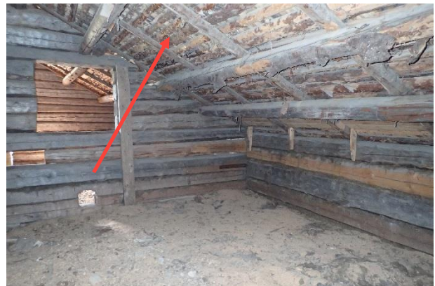
Kuva 68. Yleiskuva yläpohja- / ullakkotilasta. Peltikaton alla on vanha pärekatto. Hirsirakenteissa ei havaittu merkittäviä vaurioita.
