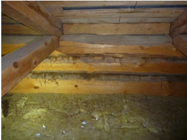
Kuva 59. Kantavahirsirunko ulottuu vesikattoon saakka.
