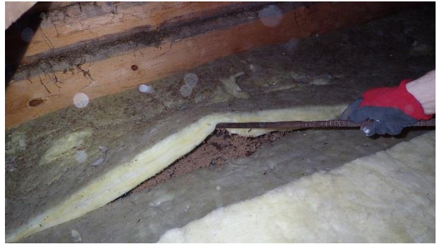
Kuva 62. Alkuperäisen lämmöneristysten päälle on asennettu 50 mm mineraalivilla levyt
