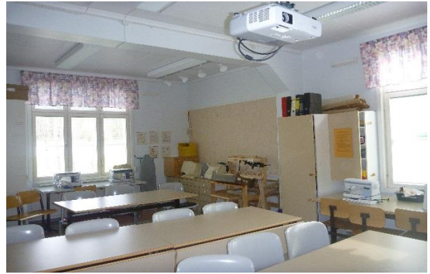
Kuva 30. Rakenneavaus RA6 tehtiin luokkaan 5.
