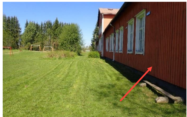
Kuva 28. Rakenneavaus RA5. Kuva rakenneavauksen kohdalta rakennuksen ulkopuolelta.
