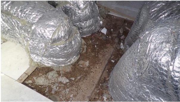
Kuva 61. Yläpohjan lämmöneristeenä on mm. sammalta.
