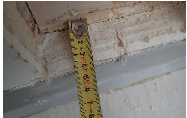
Kuva 32. RA6. Lisälämmöneristysten paksuus on noin 30 mm.
