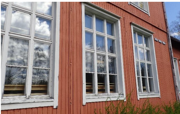
Kuva 41. Rakennuksen ikkunat ovat tyydyttävässä kunnossa.
