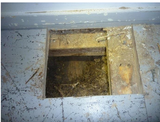
Kuva 53. RA13. Yleiskuva rakenneavauksesta.
