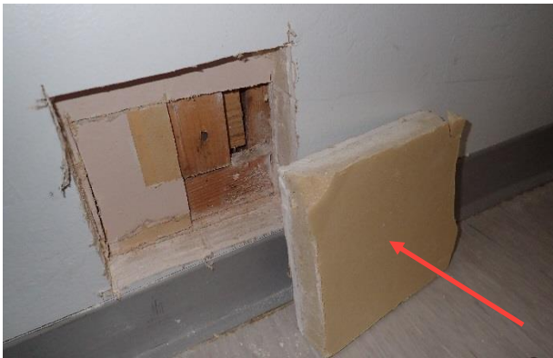
Kuva 31. RA6. Hirsiseinä on lisälämmöneristetty polyuretaani eristeellä, jonka pintaan on tehdasvalmisteisesti liimattu kipsilevy. Polyuretaani estää kosteuden siirtymisen seinärakenteen läpi.
