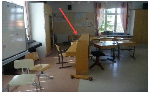
Kuva 26. Kuva luokasta 5-6. Rakenneavaus tehtiin rakennuksen päätyseinään.
