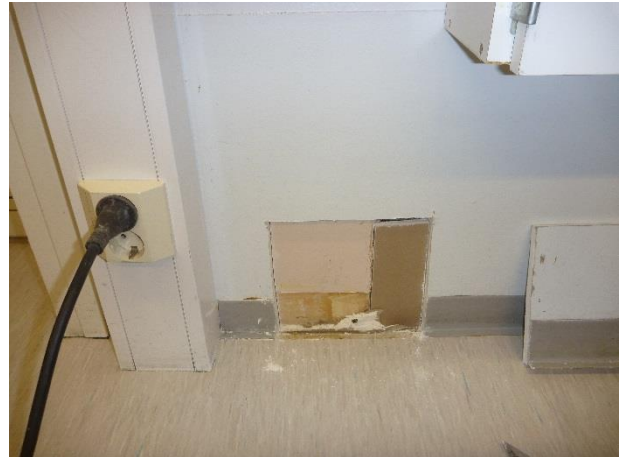
Kuva 46. Rakenneavaus RA12. Rakenneavaus tehtiin lattian rajaan, luokan oven vierelle.
