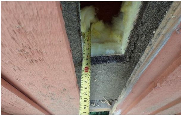
Kuva 25. RA3. Ulkoseinän lisälämmöneristys.
