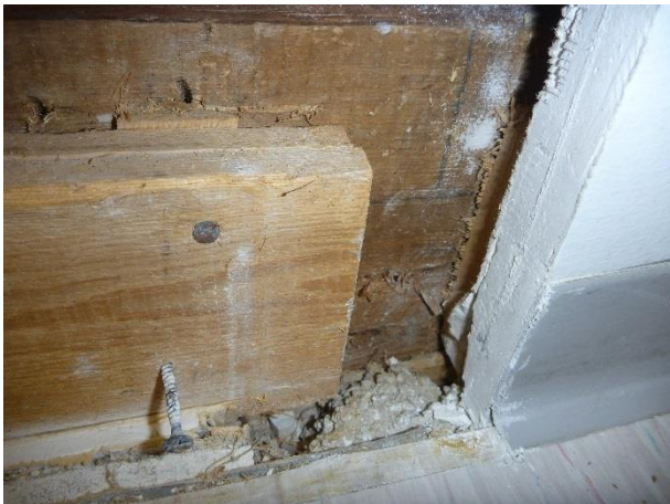
Kuva 47. RA12. Rakenneavauksen kohdalla kaksinkertainen kipsilevy. Lattiarakenteen betoni on valettu kipsilevyä vasten.
