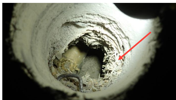
Kuva 10. RA8. Alapohjaeristeenä tojax-levy. Pohjalaattaa ei ole.
