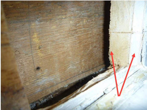
Kuva 45. RA11. Sisäverhouslevyn takana puukoolaus ja oikaisurimat. Rakenneavauksen kohdalla yksi kipsilevy.
