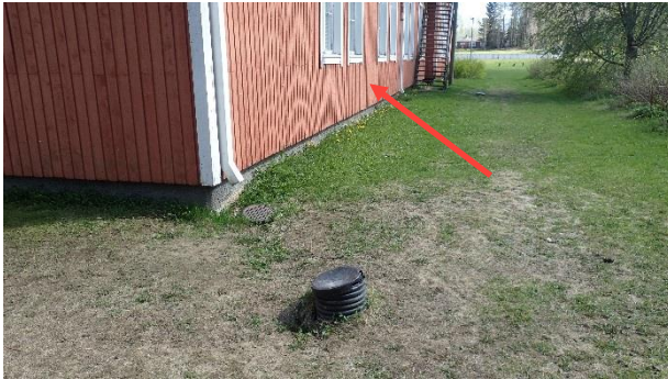
Kuva 33. Rakenneavaus RA7 tehtiin ulkoseinään. Kantavan väliseinän kohdalle.
