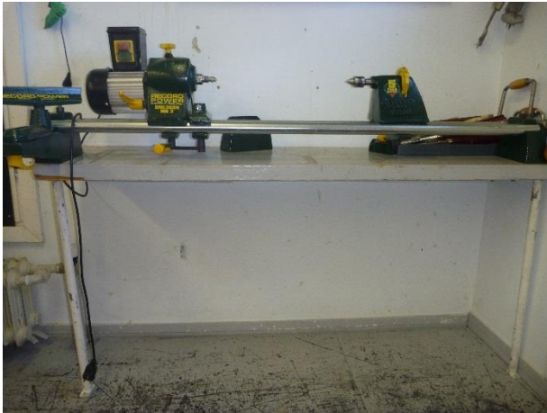
Kuva 49. Rakenneavaus RA13. Rakenneavaus välipohjaan tehtiin teknisentyötilan lattiaan.
