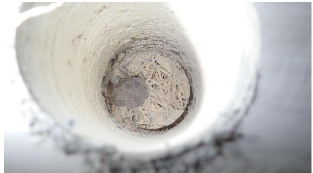
Kuva 16. RA10. Alapohjaeristeenä tojax-levy.
