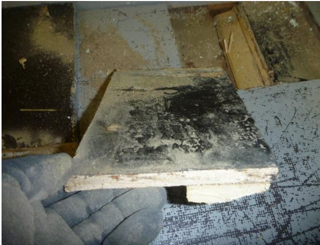
Kuva 67. Lastulevyn pinnoite, mustaliima sisältää asbestia antofylliitti.
