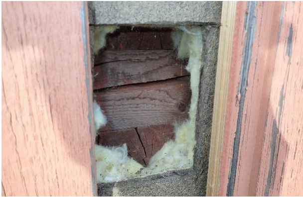
Kuva 29. RA3. Hirren ulkopuolinen rakenne on havaintojen mukaan samanlainen rakennuksen joka sivulla.
