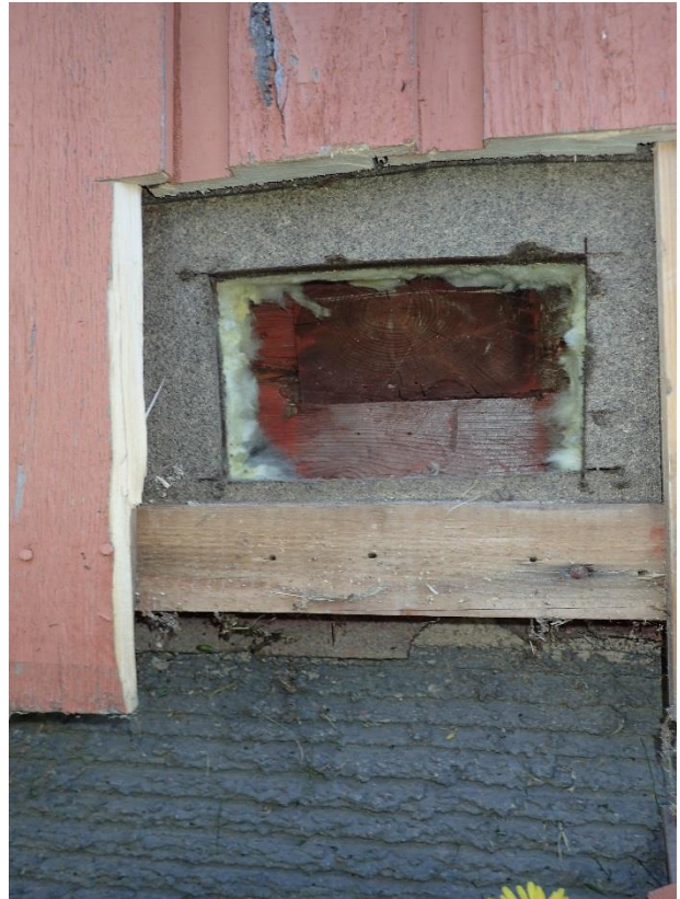
Kuva 34. RA7. Kuva kantavan väliseinän kohdalta.
