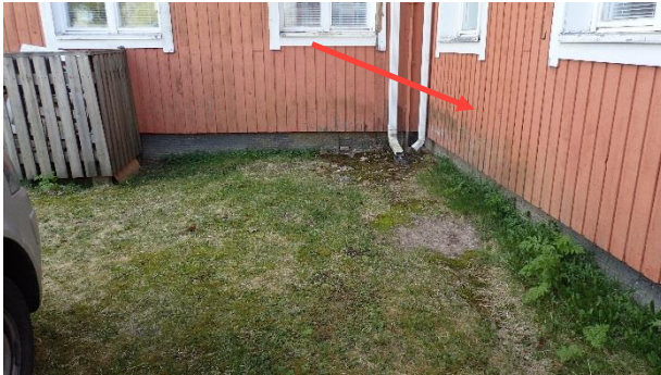
Kuva 17. Rakenneavaus RA1. Kuva rakenneavauksen kohdalta rakennuksen ulkopuolelta.
