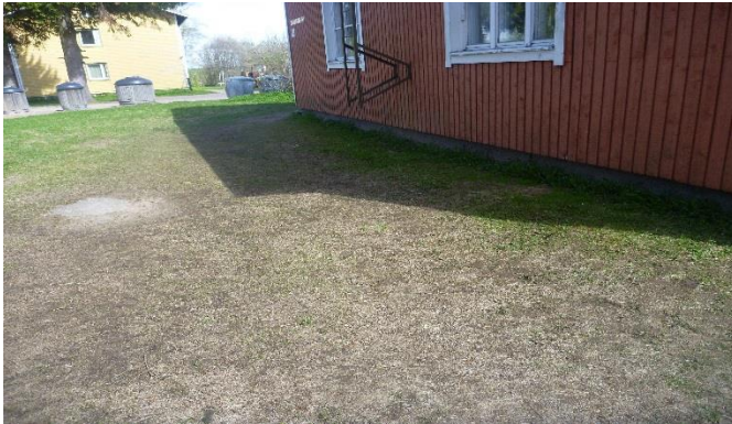
Kuva 5. Maanpinta on tasainen rakennuksen vierellä.
