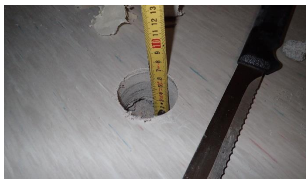
Kuva 8. RA8. Pintalaatan paksuus noin 70 mm. Lattiapinnoitteena on muovimatto.
