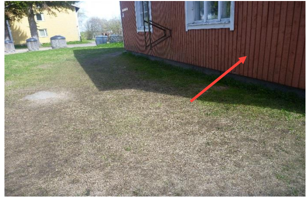
Kuva 24. Rakenneavaus RA3. Kuva rakenneavauksen kohdalta rakennuksen ulkopuolelta.
