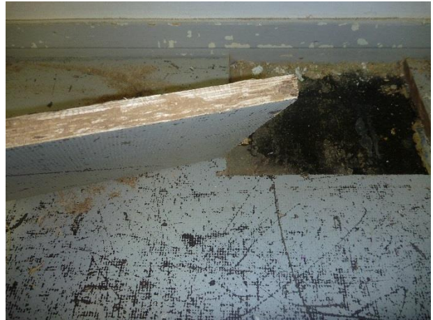
Kuva 50. RA13. Pintamateriaalina on filmivaneri.
