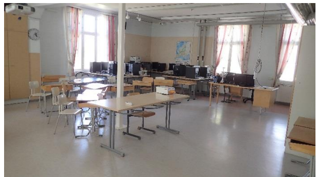
Kuva 14. Rakennavaus RA10 tehtiin luokan 5-6 alapohjarakenteeseen.
