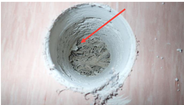
Kuva 13. RA9. Alapohjaeristeenä on tojax-levy. Tojax-levyn yläpinnassa on rakennusmuovi.
