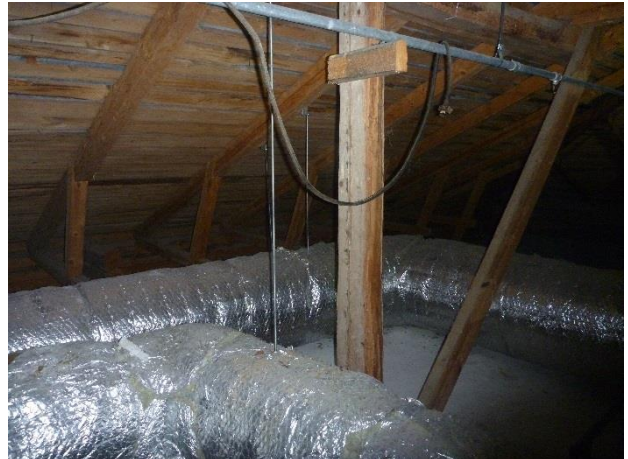
Kuva 58. Yläpohjatilasta on asennettu ilmanvaihtokanavia.
