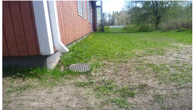
Kuva 6. Maanpinta on tasainen rakennuksen vierellä.
