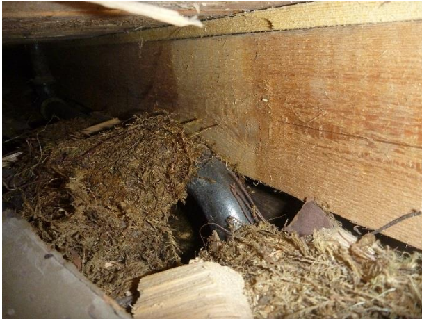
Kuva 55. RA13. Kuva välipohjarakenteen ilmatilasta. Lämmöneristeenä on sammalta ja sahanpurua.
