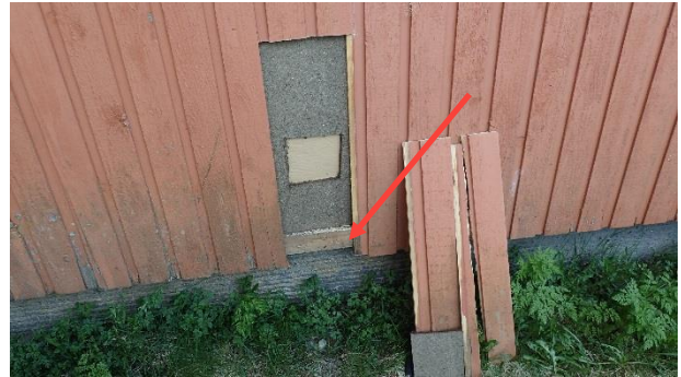
Kuva 18. RA1. Ulkoverhouksena on pystypanelointi.
