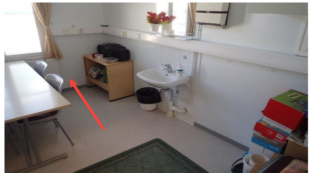
Kuva 20. Rakenneavaus RA1. Kuva rakenneavauksen kohdalta terveydenhoitajan huoneesta.
