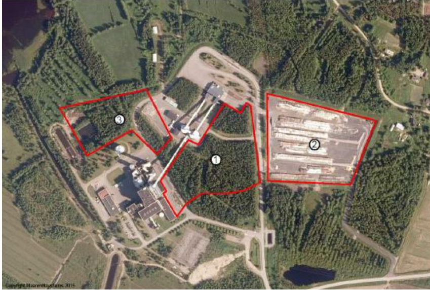
Uuden biojalostamon alustava aluevaraus olemassa olevalla voimalaitosalueella. 1-bioetanolilaitos, 2-biopolttoaineterminaali, 3-biokaasulaitos + jätevedenpuhdistamo (Lähde: Biojalostamon ympäristölupahakemus, 11.2.2019, Kanteleen Voima Oy)
