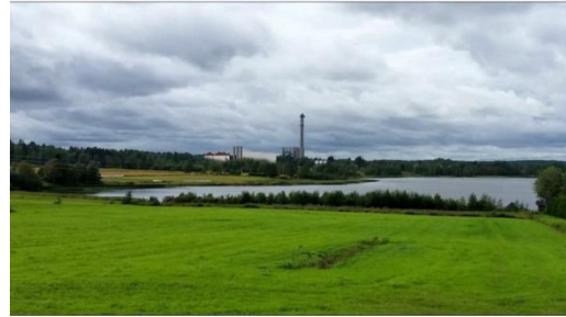
Kuva 5-48. Kuvasovite 2: Näkymä hankealueelle Kytömäentietä Mustikkamäen kohdalta. Voimalaitos ja bioetanollaitos (VE1)
