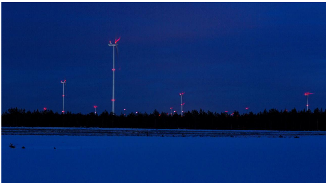
Kuva 55. Kiinteät punaiset lentoestevalot pimeällä. (Kuva: Ville Suorsa/FCG)
