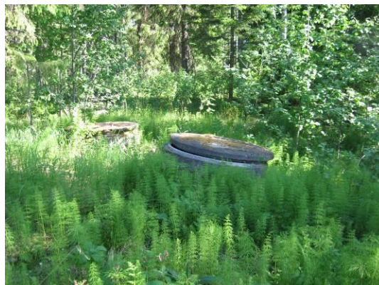
Kuva 16. Lähteeseen asennettu kaivo.
