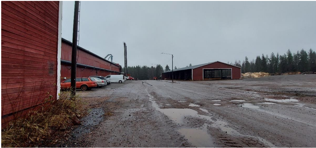
Näkymä Allastieltä kohti Sulkakyläntietä. Vasemmalla Ha-Sa Oy:n varistorakennuksia.
